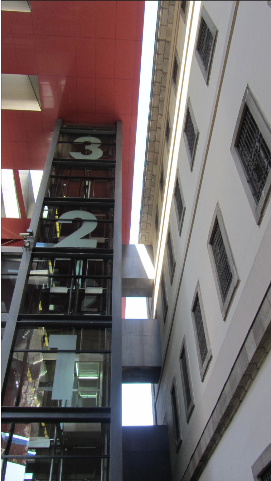
Figure 3.15 Ascenseurs de l'édifice Nouvel. (Alexandra G. Paquin, 2012.)
