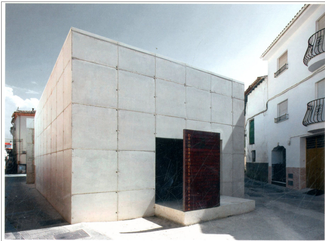
Figure 4.2 Anciens bains arabes de Baza, Espagne. Ibáñez Arquitectos, 2008. (Tiré de A & V, 2010, p. 158.)
