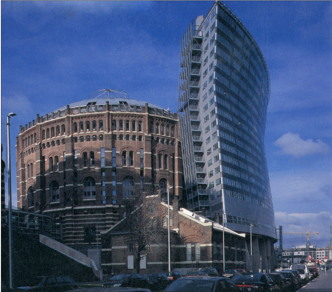
Figure 3.1 Gazomètre B, Vienne, Autriche. Coophimmel(b)lau, 2001. Les architectes ont ajouté une structure verticale au cylindre patrimonial, ancien réservoir à gaz, pour y accueillir des logements et des bureaux. (Tiré de GA document , 2002, p. 72.)
