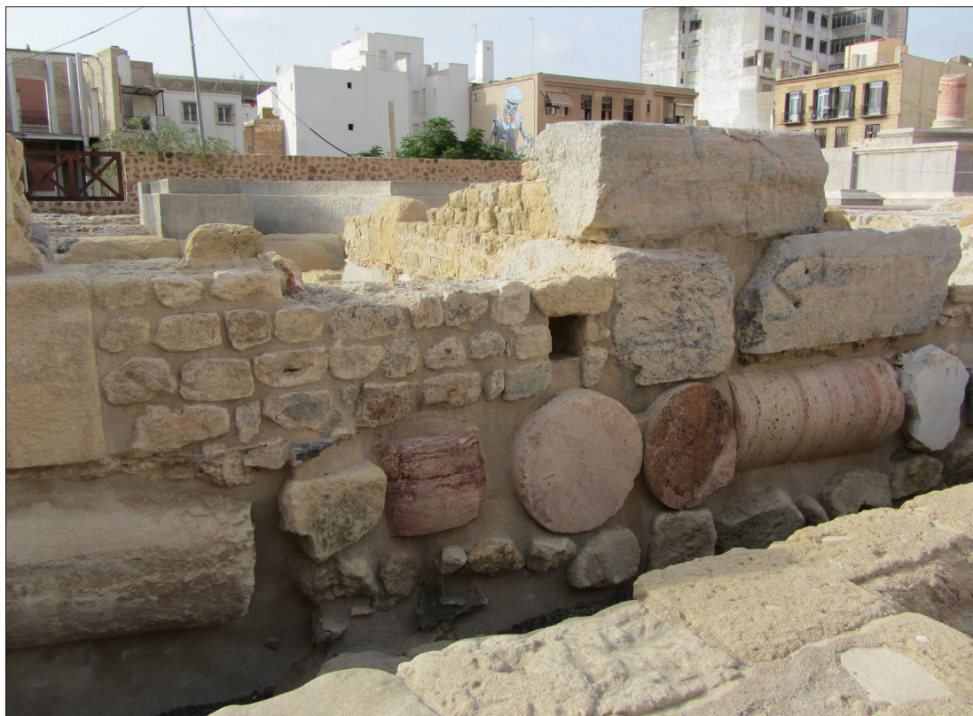
Figure 4.9 Intégration de différentes parties du théâtre dans la structure du marché du V e siècle, comme des bouts de colonnes. (Alexandra G. Paquin, 2011.)
