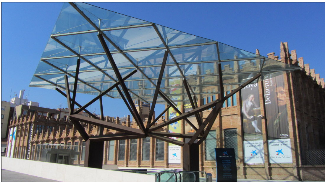
Figure 2.18 Tetsuju et marquise de verre marquant l'entrée du CaixaForum. Arata Isozaki, 2002. (Alexandra G. Paquin, 2012.)
