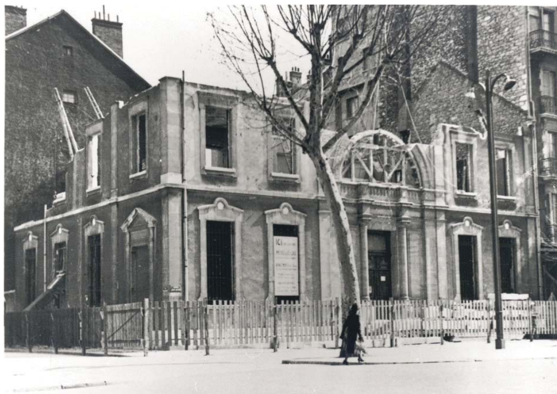
Fig. 108 : Démolition du temple maçonnique de Grenoble à l'automne 1940 (Émile Robert architecte, 1892). Sources : http://www.grenoble-resistance.fr/l/42/temple-maconnique
