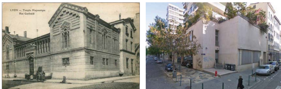
Fig. 102 & 103 : Ancien temple maçonnique de Lyon, rue Garibaldi, et temple actuel, au même emplacement (architectes et dates inconnus).
