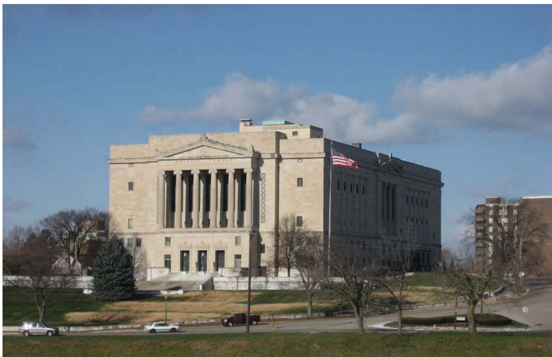
Fig. 1 : Temple de Dayton, Ohio (Hermann & Brown architectes, 1926-1928). Vue depuis l'espace public : le temple semble dominer la ville et s'assume en tant que monument. Source : https://en.wikipedia.org/wiki/Dayton_Masonic_Center
