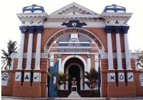
Fig. 15 : Temple de la loge «Restauracion n°55» à Puerto Plata, République Dominicaine (1902-1909, architecte inconnu) Source : https://www.flickr.com/photos/oquendo/1507220690
