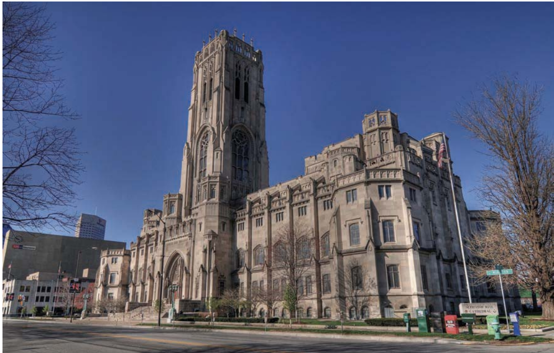
Fig. 33 : Scottish Rite Cathedral, Indianapolis, Indiana. George F. Schreiber, architecte, 1927-1929. Vue de l'extérieur. Source : https://commons.wikimedia.org/wiki/File:IPC_-_HDR_Scottish_Rite_Cathedral_%283416311251%29.jpg?uselang=fr
