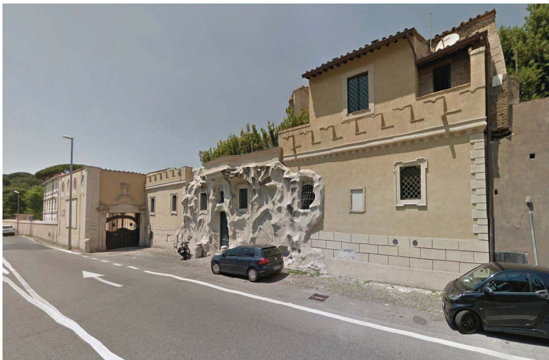
Fig. 74 : Siège du Grand Orient d'Italie à Rome (architecte et dates inconnus) Source : Streetview
