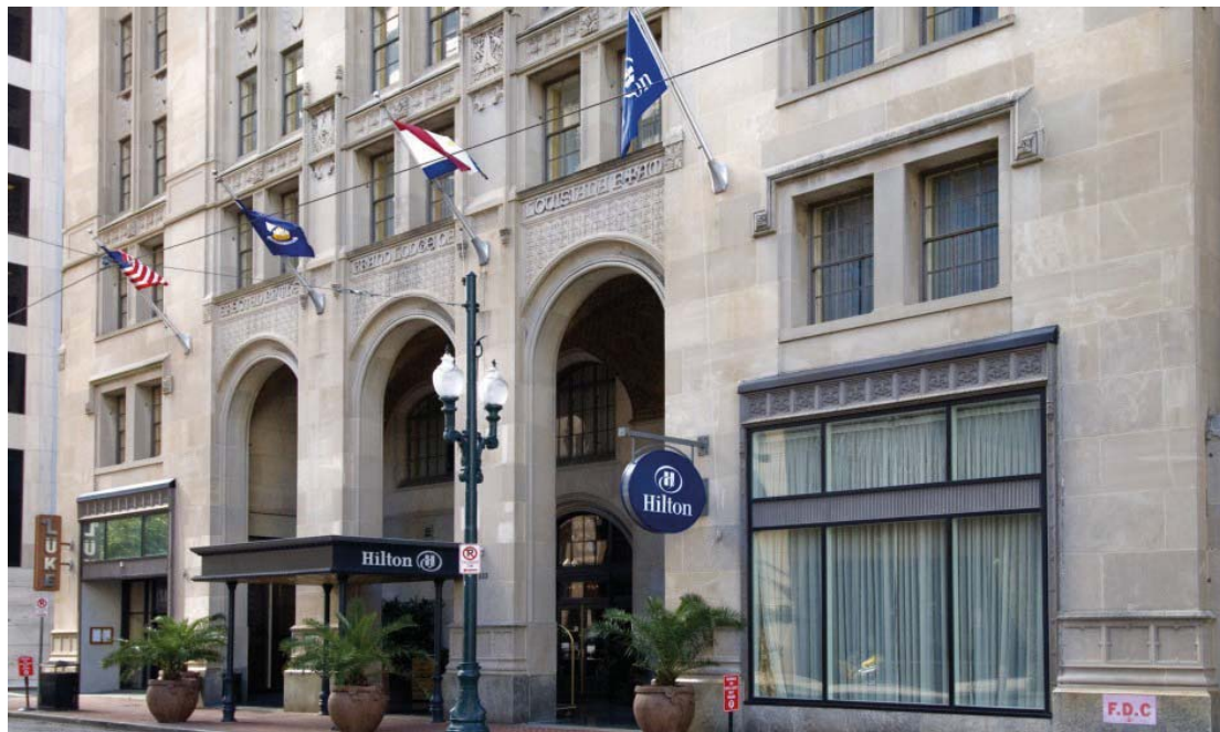
Fig. 124 : Entrée de l'hôtel Hilton à La Nouvelle-Orléans (Sam Stone, architecte, 1926). Les symboles maçonniques et la mention « Grand Lodge » sont toujours visibles sur la façade.
