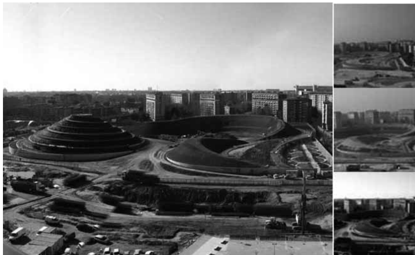
Parco del Portello, viste dall'alto del cantiere durante le diverse fasi, Milano
