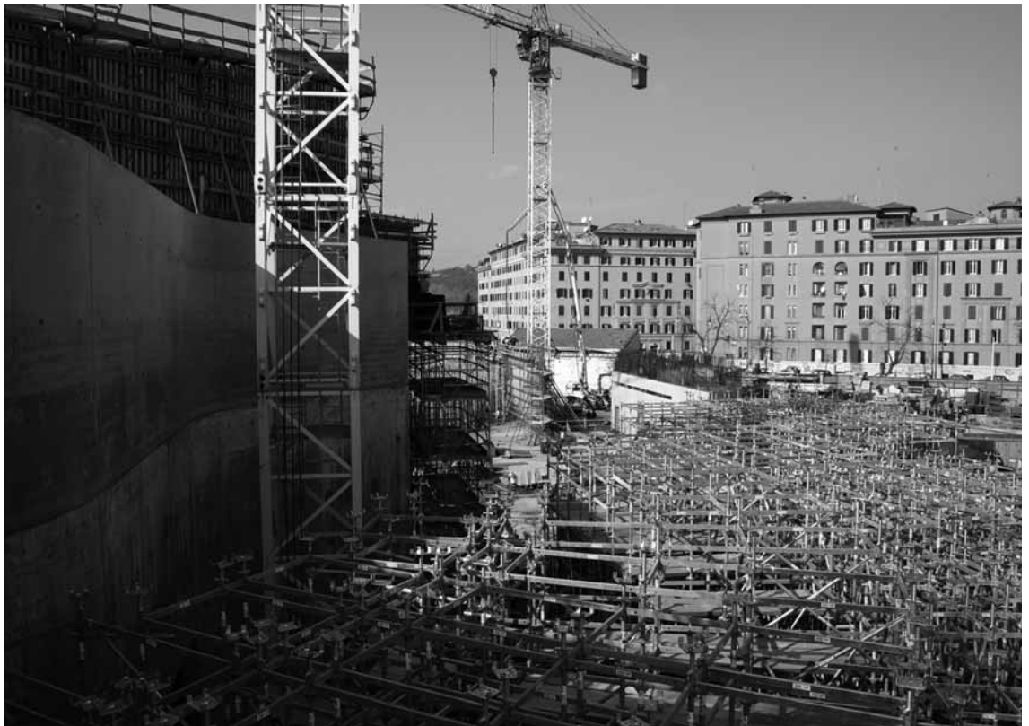
Zaha Hadid, il cantiere del MAXXI, Roma 2006 (foto di M.P.)
