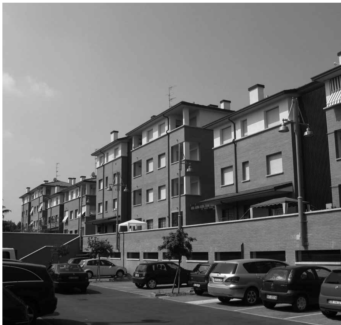
Edilizia pubblica, Pianoro Cento spa Bâtiment publique, Pianoro Cento spa
