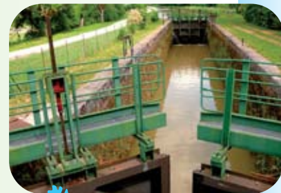
Canal de la Haute-Saône : écluse de Dambenois
