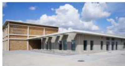
Usine d'eau potable Georges Debaïlle
