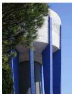
Château d'eau de Marseillan
