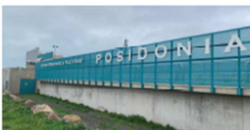
Station d'épuration Posidonia - Agde
