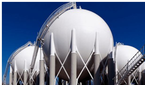
Figure 4 : Stockage cryogénique de l'hydrogène (un réservoir de 40\,000\ m^3 est actuellement à l'étude).
