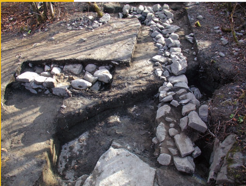
Fondations d'un bâtiment sur le site patrimonial du Poste-de-Traite-de-Chicoutimi
