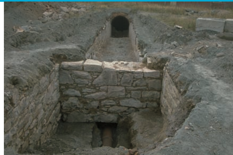
Fondations d'une caserne et d'une caponnière, fort Numéro-Trois de Lévis Parcs Canada
