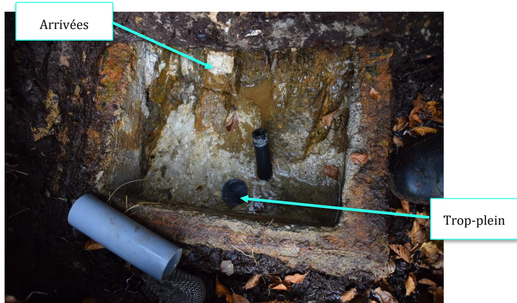
Illustration 16 : Clichés de l'intérieur du captage de « Matech aval »
