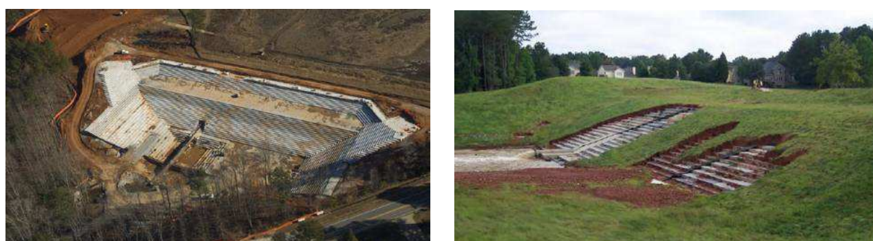
Figure 6 : YELLOW RIVER #Y15 (en travaux avant mise en place terre végétale et état après la crue de 2009)
