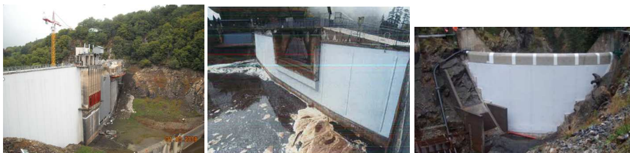
Figure 6 : Saint Marc à la fin des travaux en 2008 (à gauche), Le Saillant terminé (au centre) et Rioumajou à la fin des travaux (à droite)
