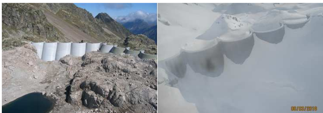
Figure 5 : Migoëlou à la fin des travaux en 2008 (à gauche) et durant l'hiver 2018 (à droite)
