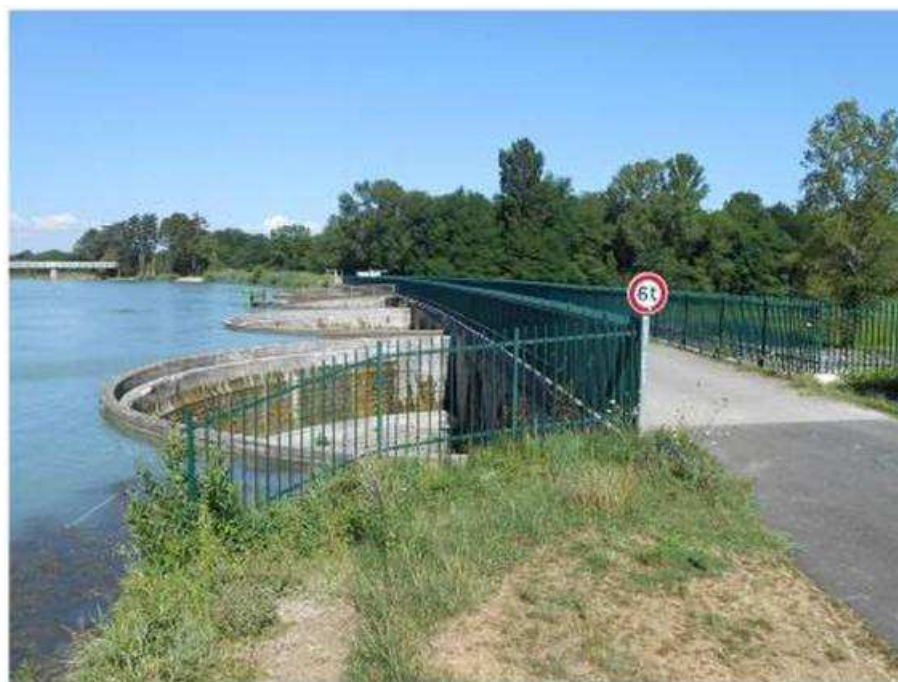
Photo 1 : Vue générale du déversoir depuis l'amont du canal – 2016
