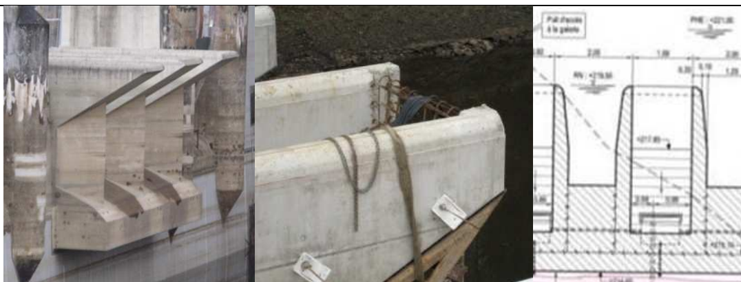
Figure 10 – a) Nez et poutre amont au PKW de Saint-Marc, b) Mur parapet au PKW de l'Étroit, c) Mur latéral d'épaisseur variable au PKW de La Ravière
