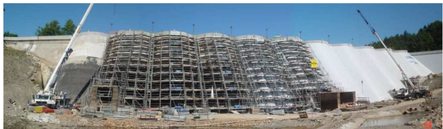
Figure 8 : Vue d'ensemble de Vaité 2 après mise en place du dispositif d'étanchéité (gauche), échafaudage de 5 voûtes adjacentes à Butgenbach (droite)
