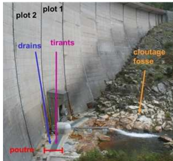
Figure 13 – poutres terminées à l'aval des plots 1 & 2.
