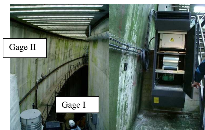
Figure 5 Photos de l'espace inter-voûtes et du système de chauffage
