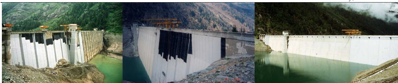
Figure 8 : Scais travaux en 1993 (à gauche) et en 1995 (au centre) et ouvrage terminé (à droite)
