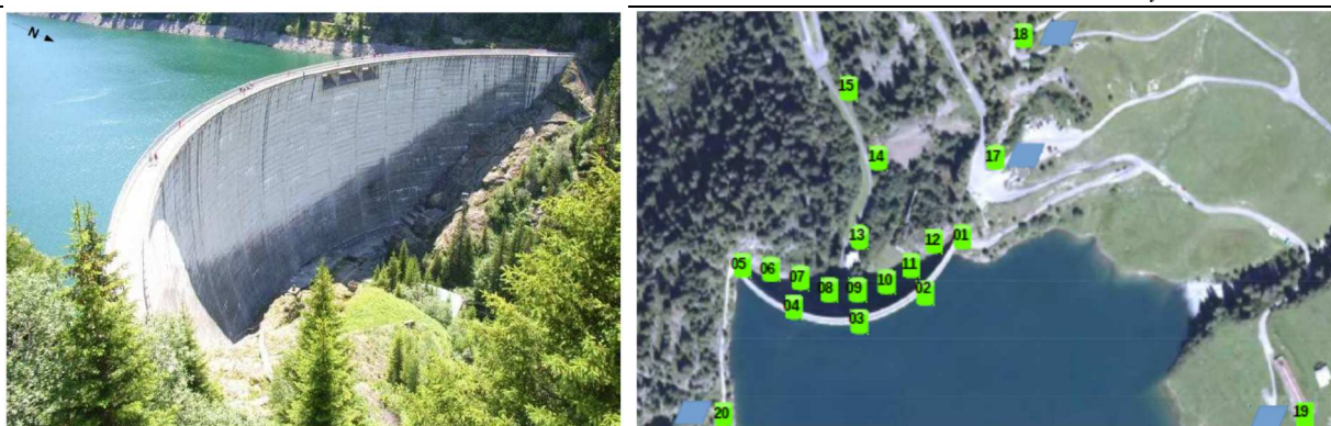
Figure 7 : Barrage de Saint Guérin – système d'enregistrement vélocimétrique
