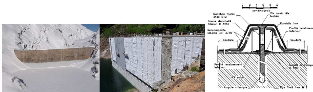
Figure 7: Gnioure 1 ère campagne achevée (à gauche), lors des travaux de la 2 nde campagne (au centre) et détail des profilés de mise en tension (à droite)
