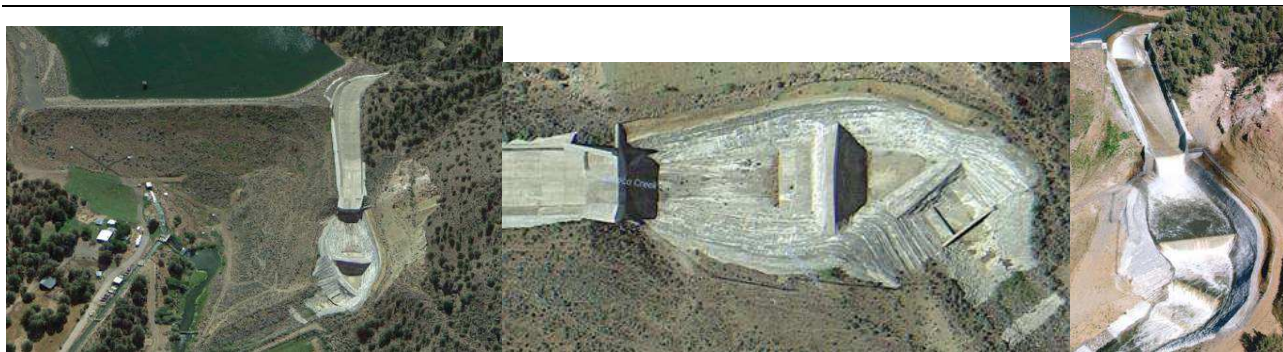
Figure 13 : OCHOCO bassin dissipation (vues aériennes après travaux et vue d'aval avec l'évacuateur en opération)
