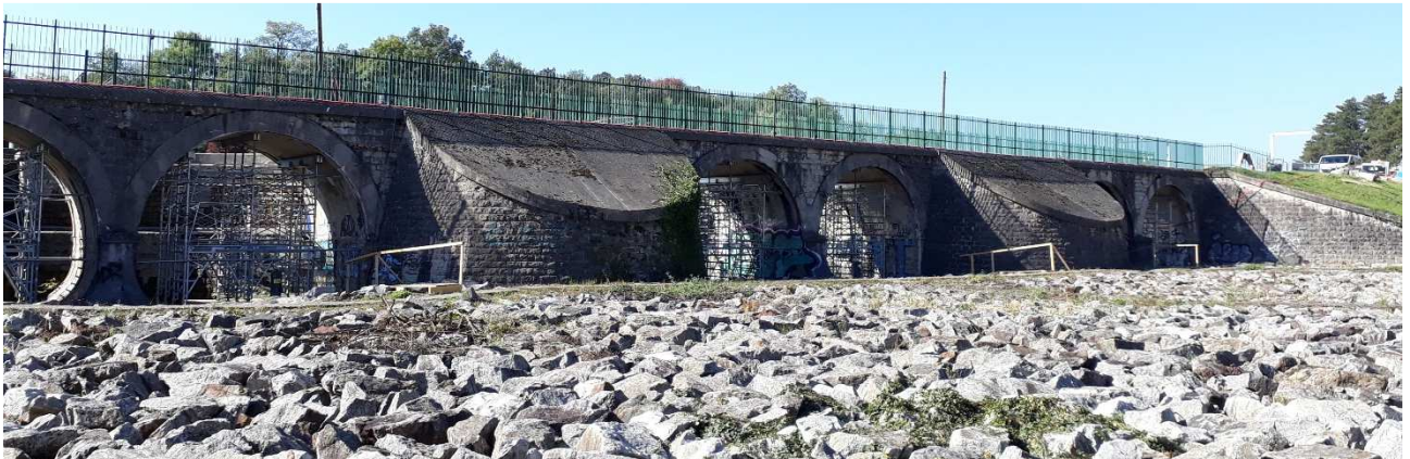
Photo 2 : Vue des enrochements à l'aval du déversoir
