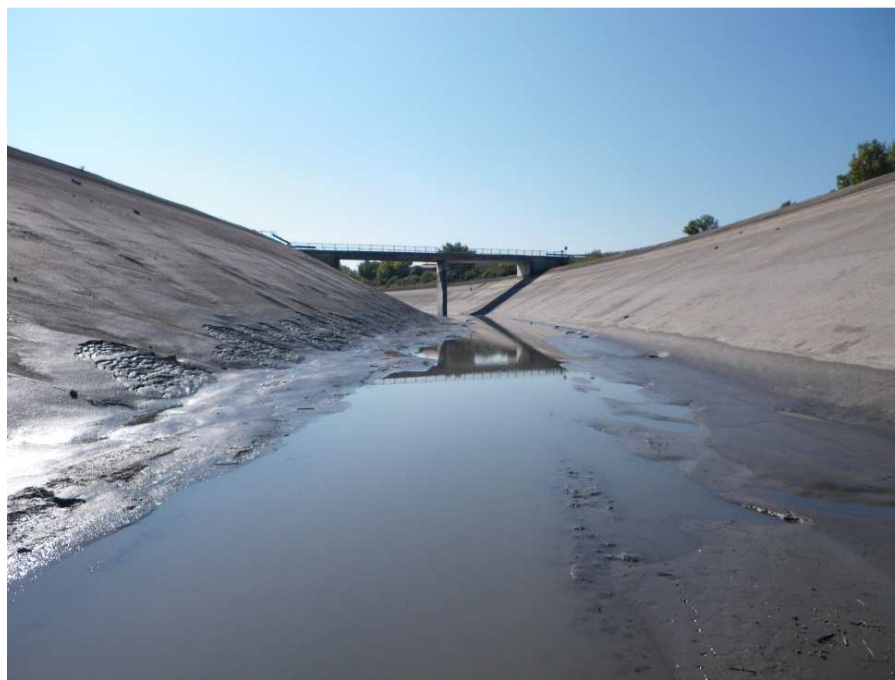
Figure 2 : Photo du canal de Sisteron vidangé en 2011
