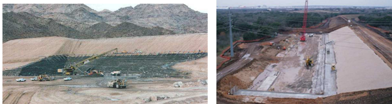
Figure 7 : Mise en œuvre du BCR à HIKO SPRINGS (à gauche) et SALADO CREEK #15 (à droite)
