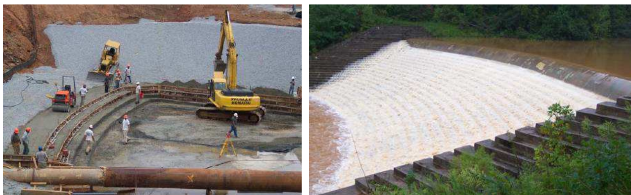
Figure 5 : YELLOW RIVER #Y14 (pendant les travaux en 2003 et pendant la crue de 2009 – sans terre végétale)
