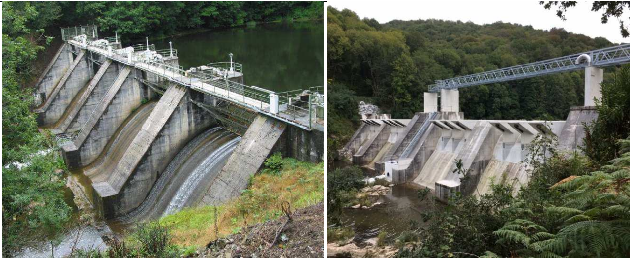
Figure 8 – a) PKW du barrage Record avant, b) après les travaux
