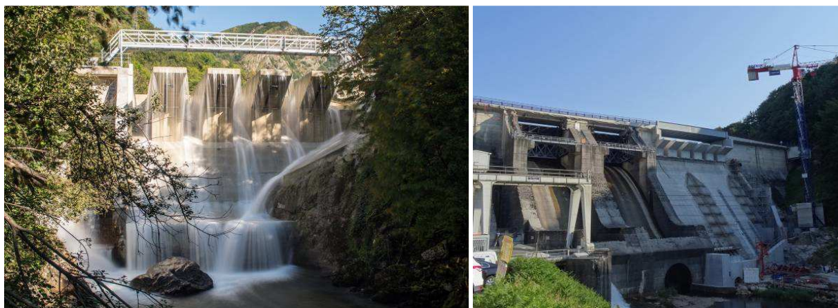
Figure 7 – a) PKW du barrage de Campauleil, b) PKW du barrage de La Raviège
