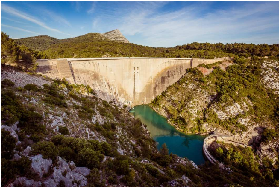
Figure 1 : Barrage de Bimont (Crédit Photo N. PELLETIER SCP)
