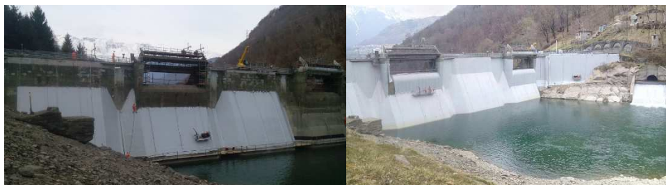
Figure 9 : Poggia travaux en 2016
