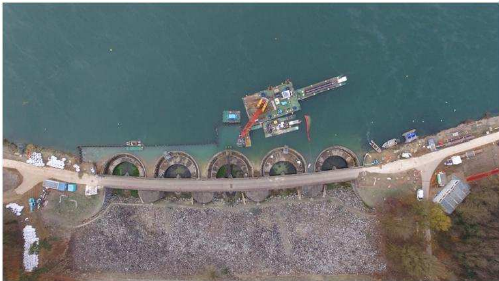
Photo 4 : Vue aérienne du chantier (contournement du chenal de vidange en cours)
