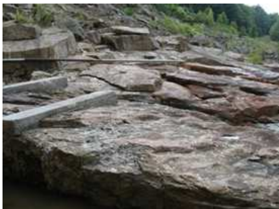
Figure 9 : desquamation du rocher de surface.
