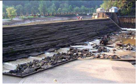
Figure 2 : OCOEE#3 (profil et état après plus de 3 000 déversements intentionnels et une forte crue)
