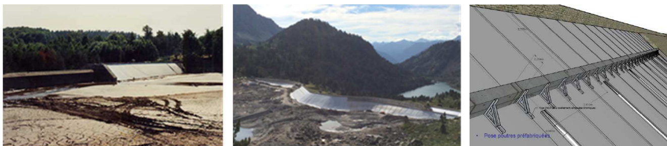
Figure 1 : Barrage de Cruetize (à gauche) et d'Aubert (au centre en 2014) et détail du système de support du perré (à droite)
