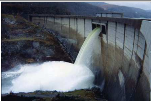
Figure 5 : évacuateur de crues vu d'aval (déversement passes RD & centrale – fonctionnement simultané vidange de fond).
