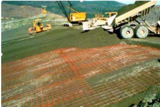
Figure 3 : NORTH FORK TOUTLE River (placement du BCR et état du coursier après 11 mois de service)
