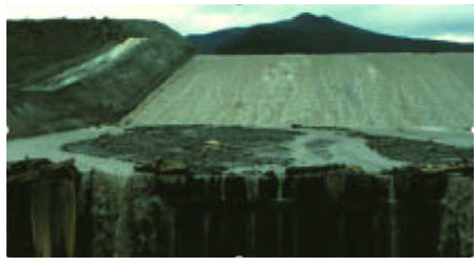
Figure 3 : NORTH FORK TOUTLE River (placement du BCR et état du coursier après 11 mois de service)
