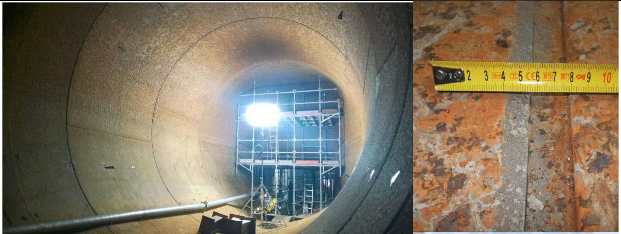
Figure 4 : Vue depuis l'amont (A gauche) et vue d'une soudure (A droite).
