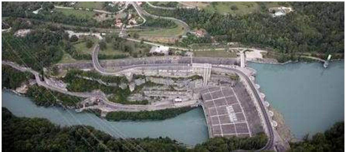
Figure 1 : Vue aérienne du barrage de Génissiat.
