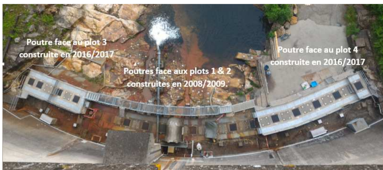
Figure 14 : implantation des poutres construites en 2008-2009 et 2016-2017.
