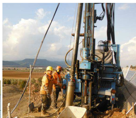
Figure 2 : Atelier de carottage avec la méthode Düsterloh
