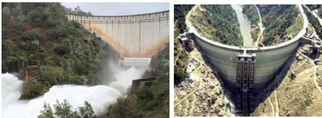
Figure 1 : barrage de Cabril
