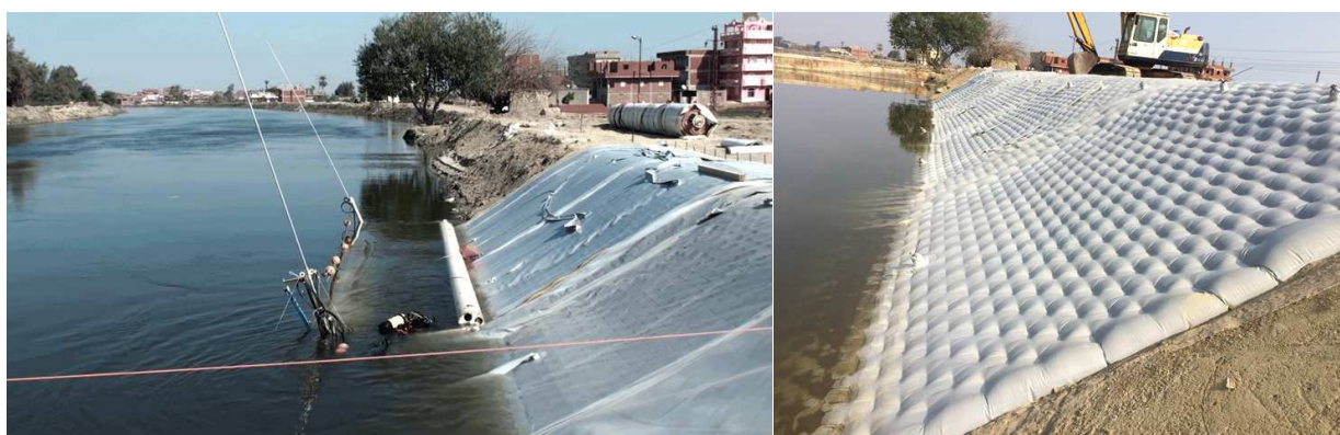
Figure 10 : Installation du matelas SIBELONMAT ® au canal d'Ismaïlia, Egypte 2016
