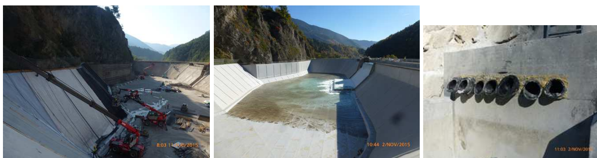
Figure 2 : Saint Martin Vésubie pendant les travaux (à gauche), durant le remplissage (au centre), et exutoire des drains du DEG (à droite)
