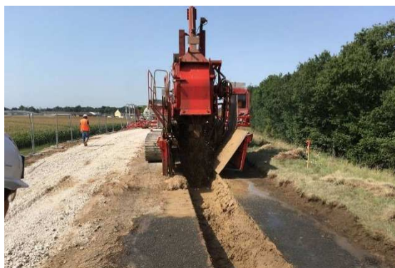
Figure 6 : Chantier 2017 de renforcement de l'étanchéité dans la levée d'Orléans
