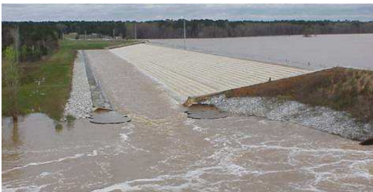
Figure 4 : LAKE THOLOCCO (crue de 2004 et état des marches du coursier après 14 ans de service)
