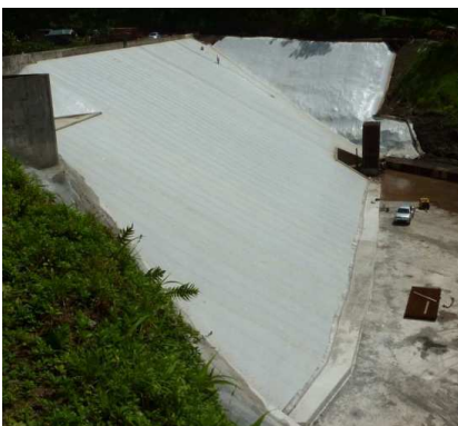
Figure 8 : Vue d'ensemble de Vaité 2 après mise en place du dispositif d'étanchéité (gauche), échafaudage de 5 voûtes adjacentes à Butgenbach (droite)
