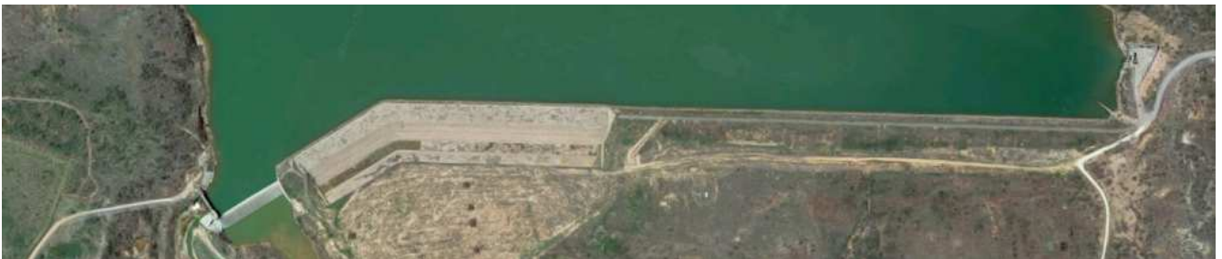
Figure 9 : LAKE DIVERSION (vue aérienne du barrage)
