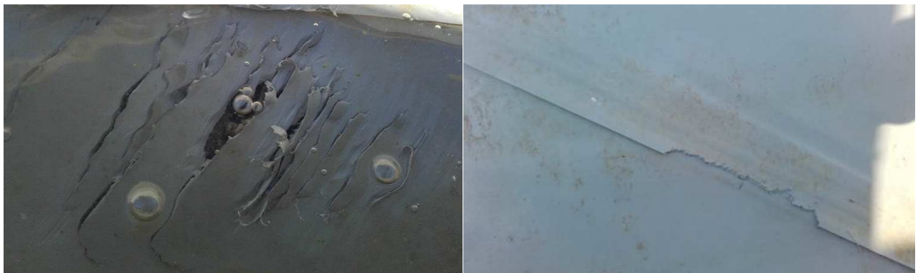
Figure 11 : Détail des griffures et morsures de la géomembrane de Pannecière
