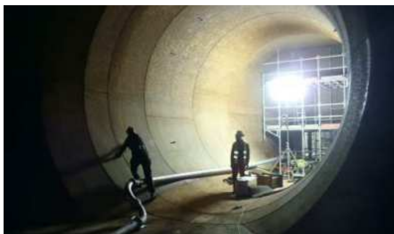
Figure 10 : Aperçu des conditions d'intervention lors du contrôle du blindage.
