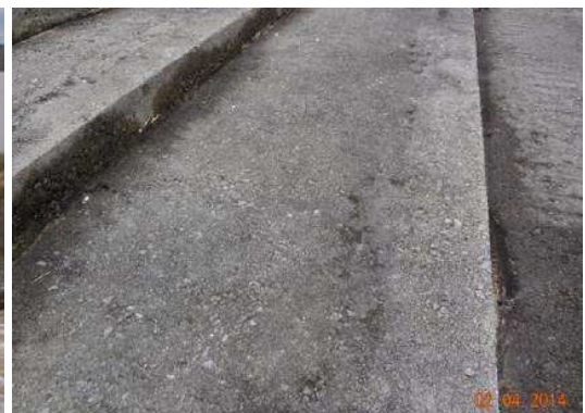
Figure 4 : LAKE THOLOCCO (crue de 2004 et état des marches du coursier après 14 ans de service)
