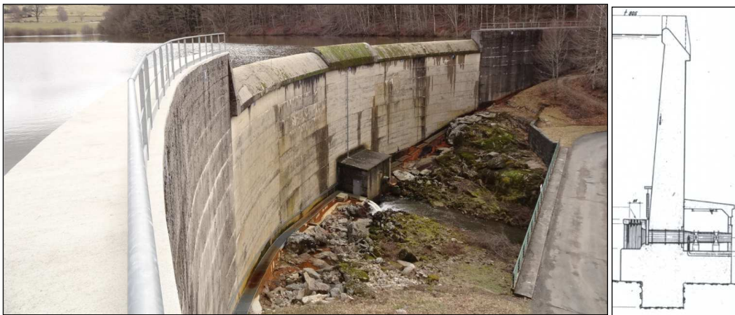
Figure 6 : Photographie du barrage des Galens (à g.) et coupe sur console de clé (à dr.)
