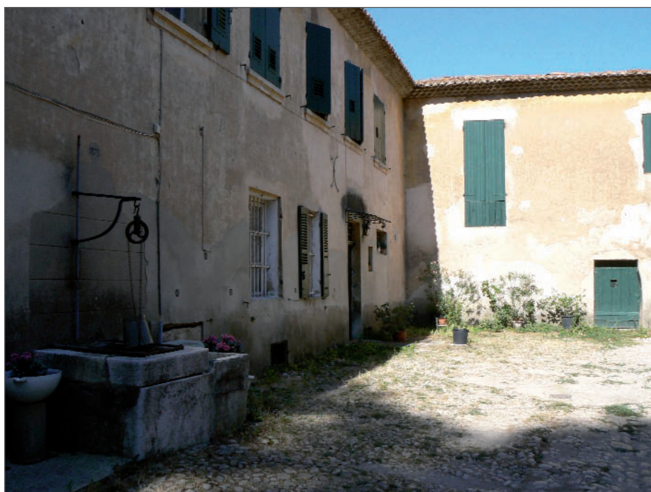
Bastide de Reboulon - Cour intérieure
