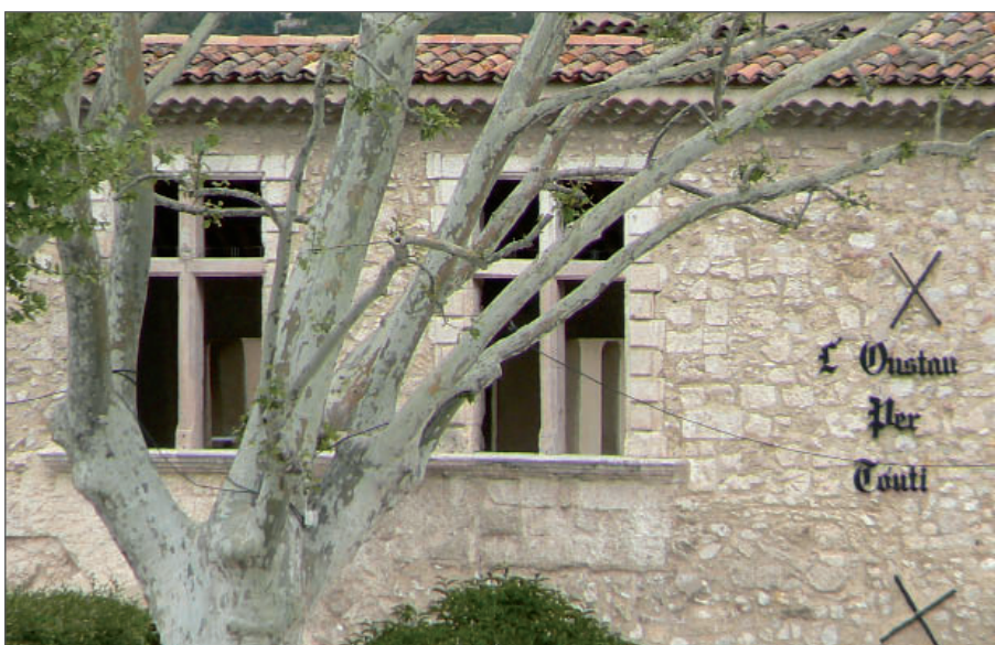
Château de Trébillane - Fenêtre renaissance
