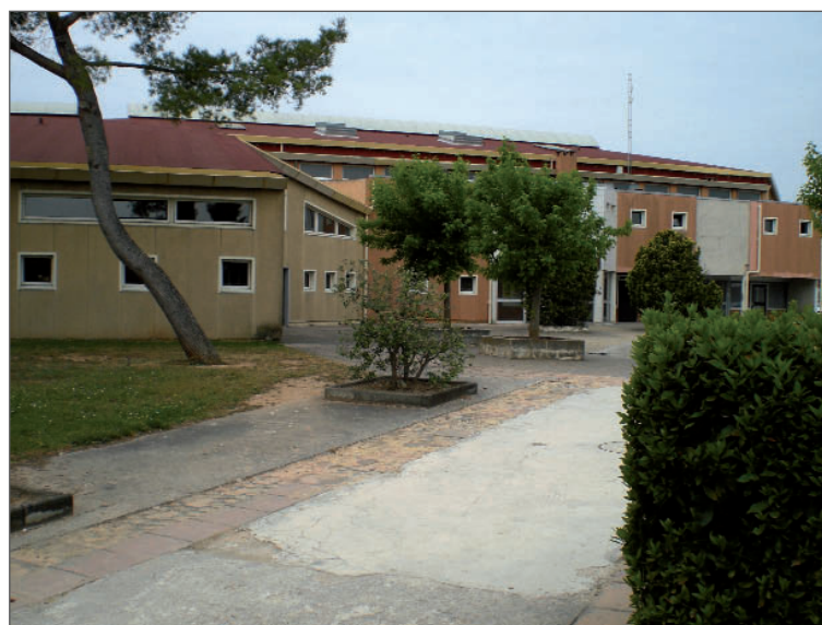
Complexe sportif Raymond Martin - Bâtiment principal
