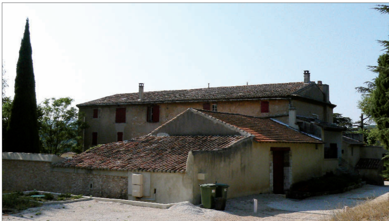
La Bastide Blanche - Vue d'ensemble côté ferme
