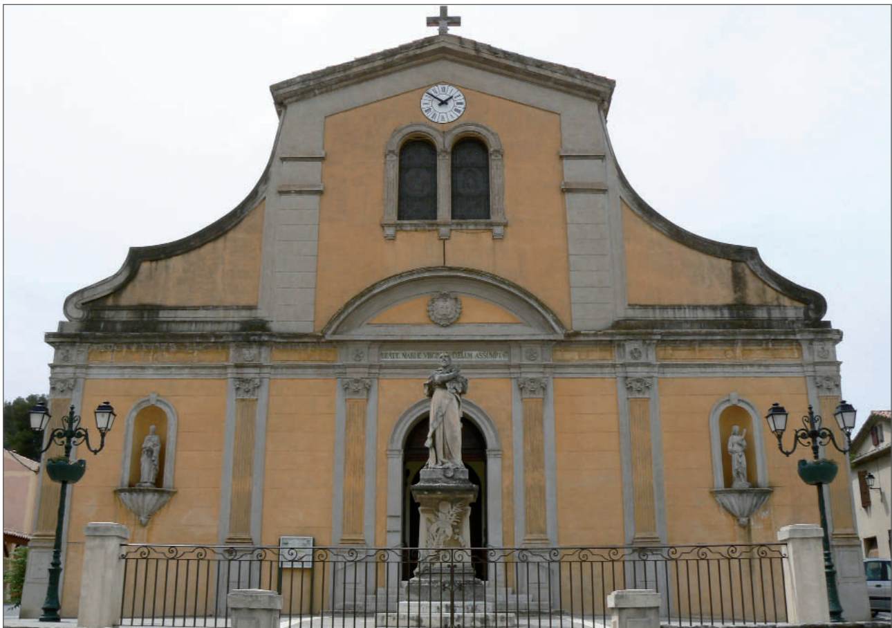
L'église - la façade
