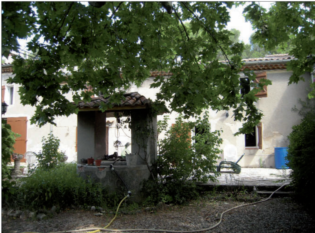
La Bastide de Josselet - Façade et puits - Etat actuel (photo : OA)
