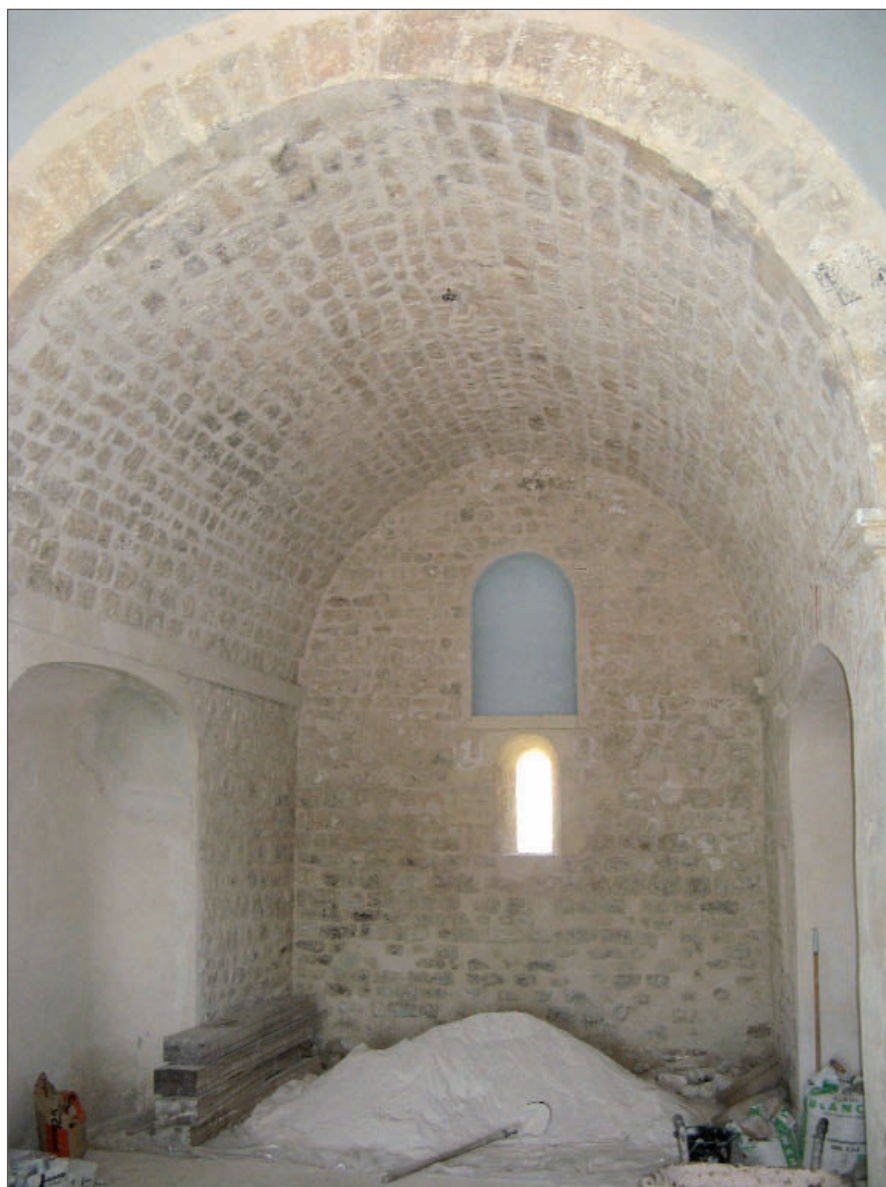
Chapelle de Trébillane - intérieur pendant sa restauration
