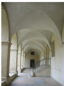
Voûte d'arêtes, Couvent des Augustins, Crémieu (Isère), fondé au XIV e siècle, remanié jusqu'au XIX e .
