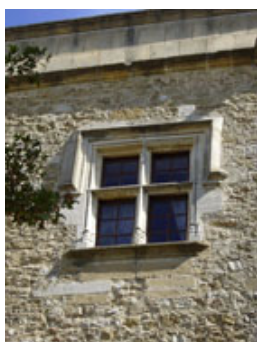
Croisée, Château de Lourmarin (Vaucluse), XVIe siècle.
