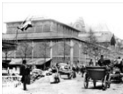
Halles Centrales de Paris à l'angle des rues Baltard et Berger en 1889-90.
