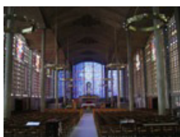
Eglise Notre-Dame du Raincy. Le Raincy (Ile-de-France), Auguste Perret (1874-1954), 1922-1923.
