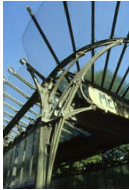
Marquise de l'édicule Dauphine. Bouche de métro parisien réalisée en 1900 par Hector Guimard (1867-1942).
