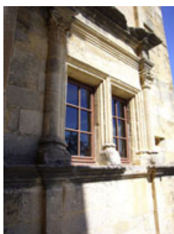
Fenêtre à meneau, Château de Lourmarin (Vaucluse), XVIe siècle.
