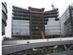
Chantier : mise en oeuvre d'un mur-rideau. Londres, 2006.
