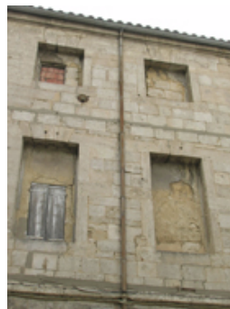
Fenêtres bouchées. Maison rue du Four des Flammes à Montpellier.
