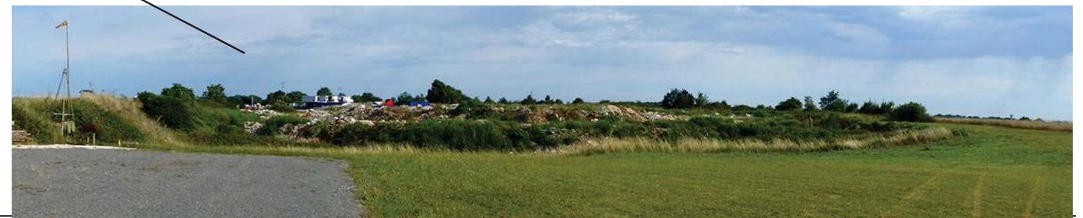
La déchetterie de Trizay vue depuis le terrain d'aéromodélisme au Sud du site
