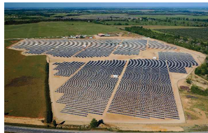
Parc Solaire avec Trackers – 12 MWc Arles (13) Foncier Privé → Développement, Financement, Construction et Exploitation → Ancienne carrière
