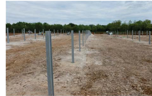
Figure 19 : Ancrages de type pieux battus
