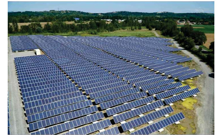
Parc Solaire avec Trackers – 4.5 MWc Lavernose (31) Foncier Communal → Développement, Financement, Construction et Exploitation → Ancienne gravière remblayée / Site BASIAS
