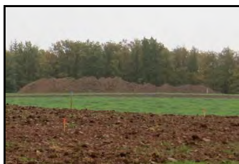
Figure 112 : Terre végétale stockée sur un chantier de centrale photovoltaïque (Source : Abies, suivi de chantier)
