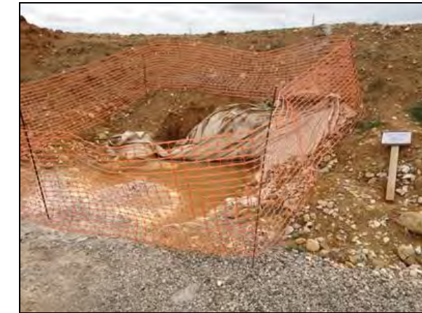
Figure 108 : Exemple d'aire de lavage des toupies sur un chantier de parc éolien (source : source : Abies, S. Albouy)
