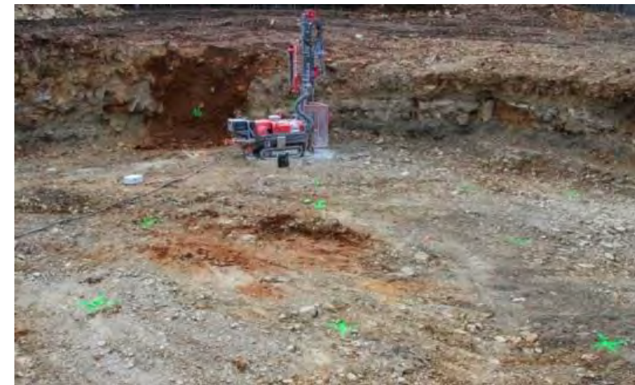
Figure 107 : Foreuse géotechnique sur un chantier éolien (source : Abies, S. Albouy, 2014)
