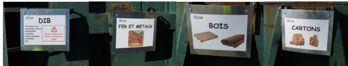
Figure 111 : Affichages sur des bennes de tri sélectif (Source : Abies, suivi de chantier de centrale photovoltaïque)
