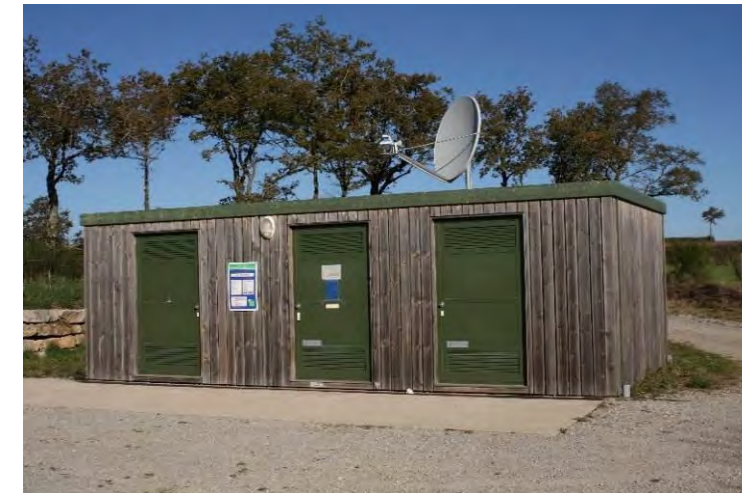
Figure 115 : Bardage bois et peinture vert foncé (source : ABIES)
