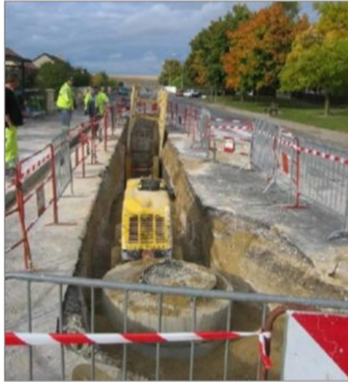
Fig. 7. Exemple d'ouverture de tranchée pour réhabiliter le réseau EU
