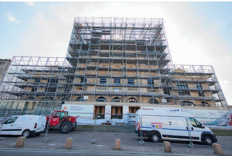
La bâche de chantier a été déposée le 9 mars dernier, dévoilant en partie la façade restaurée et ses pierres sculptées.
