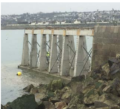
L'armature de la nouvelle digue a été posée. Fin des travaux prévu au printemps.
