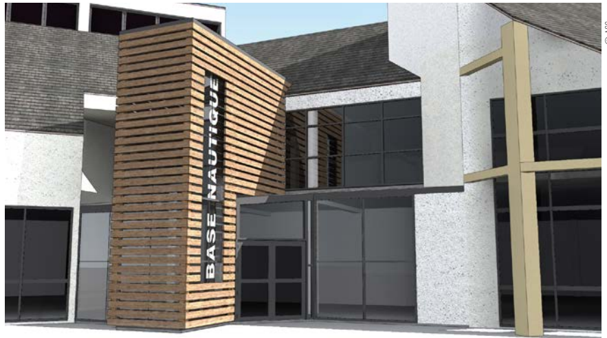
La mise aux normes PMR de la base de Collignon s'accompagne d'un relookage de la façade, qui accueillera désormais un ascenseur habillé d'un bardage bois.
