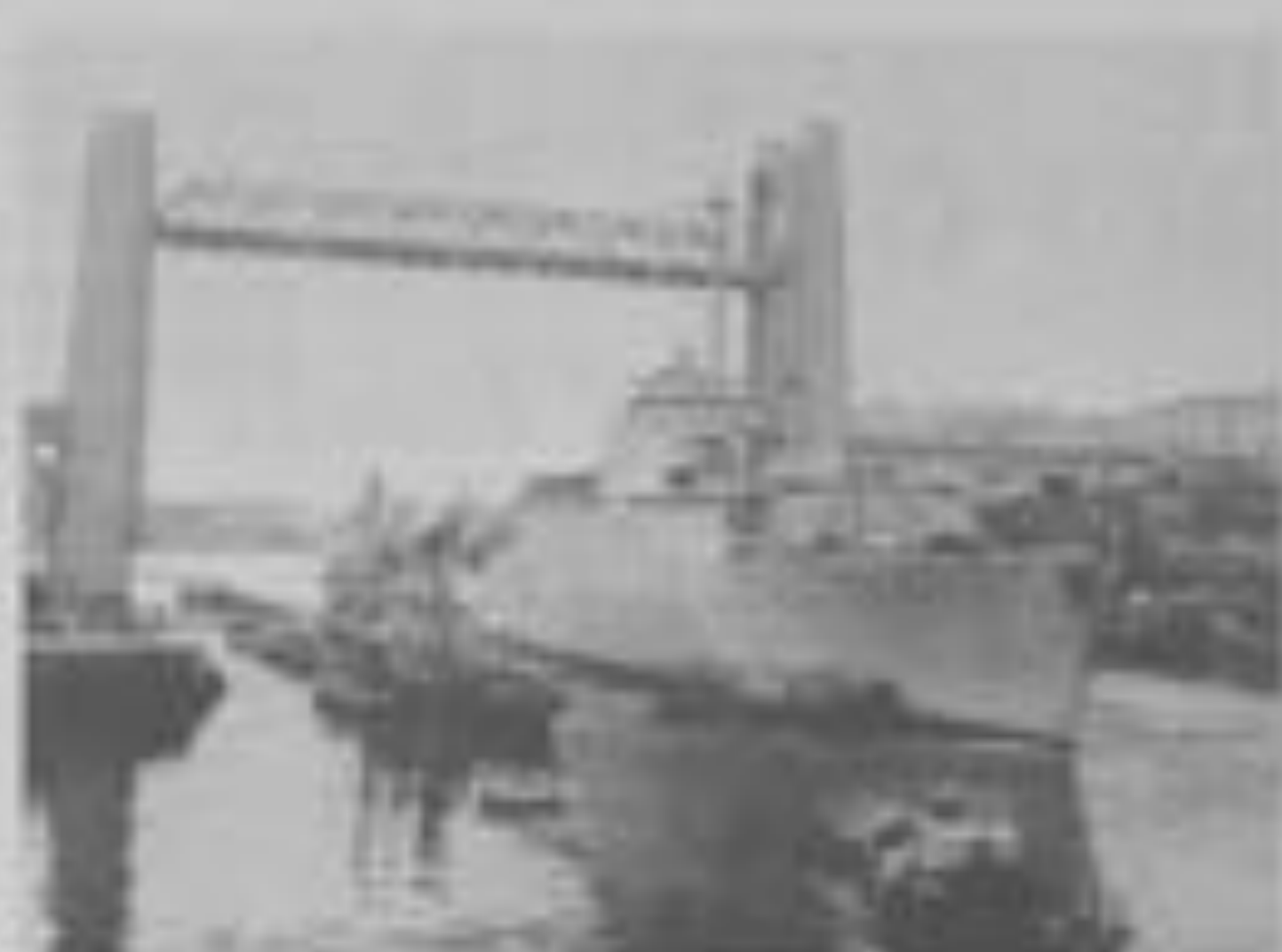
Remont du Paillasse à l'É.D. - Coupure à pied avec le grand pont
