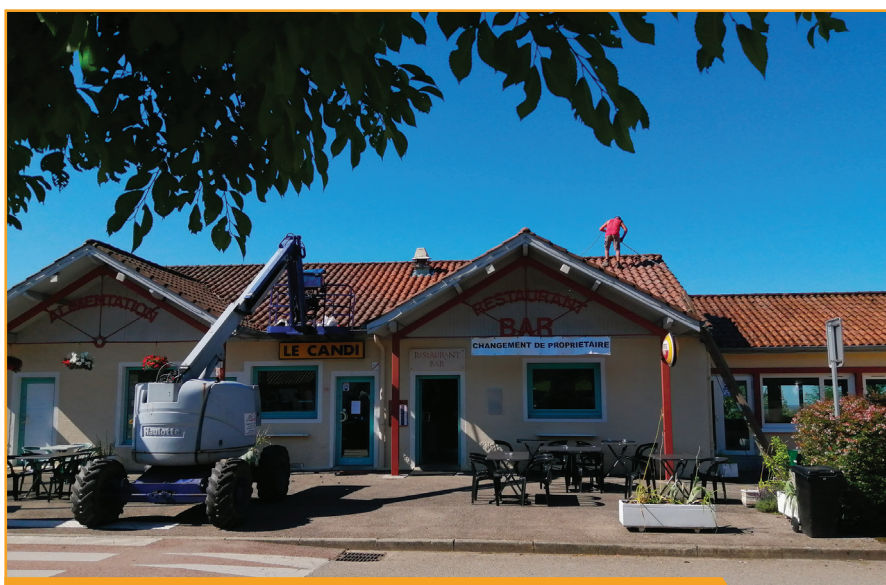
Le Candi en travaux avant réouverture
