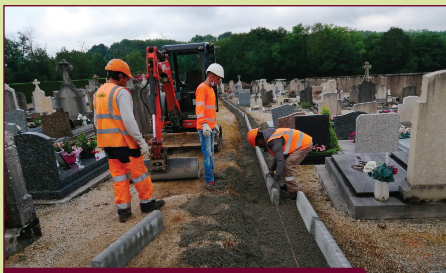
Pose des bordures
