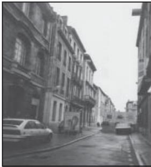
Rue Saint Siméon et, au fond, les travaux du métro en 1990 Photo de Ana Suely Ferreira
