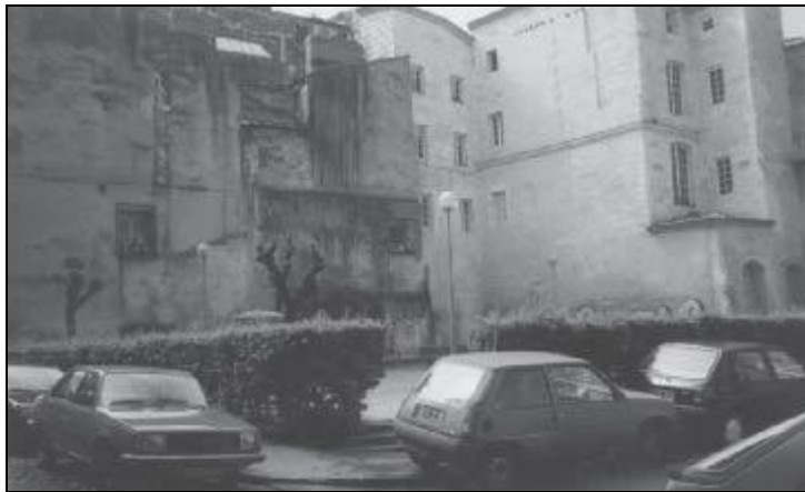
27, Rue Neuve– Immeuble démoli – avril 1999
