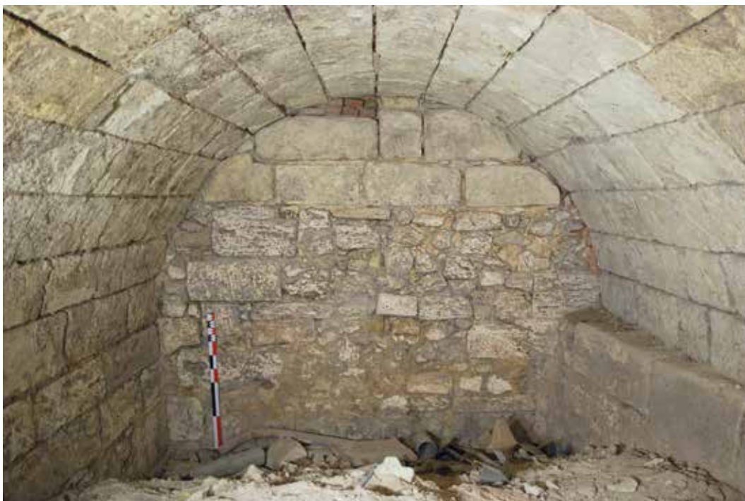
Blois, le Château, la salle voûtée de la fosse latrine sous l'escalier Louis XII (Pièce L.S. 00.04). Vue générale du mur ouest prise depuis l'est (éch. 1 m). Noter les deux dernières assises en pierre de tuffeau, taillées pour se conformer au profil de la voûte (S. Bryant, Inrap).
