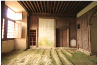
•LA CHAMBRE A ALCÔVE L'ensemble de la pièce présente une humidité maximale, malgré la mise en place de déshumidificateur sur une période de plusieurs mois. Le sol, les murs, les boiseries seront restitués selon le parti scénographique retenu.
