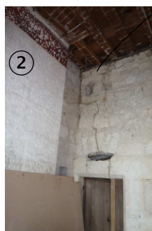
• LE SALON DORÉ (1er étage) La dépose des tentures murales et la mise en oeuvre d'un enduit à la chaux a permis d'assainir la pièce et de réduire pour partie l'hygrométrie ambiante.
