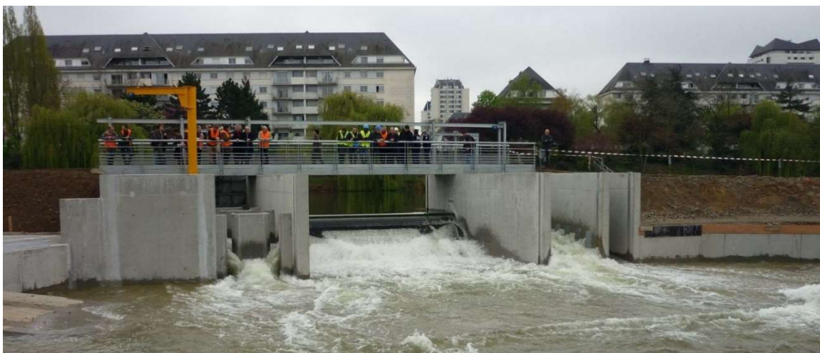
Figure 45 : Un exemple de mutualisation des ouvrages, à Tours (36) ; de gauche à droite : une passe à poissons bassins, une vague toit, une passe à ralentisseurs, une passe spécifique à anguilles de type dalle à plots
