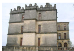
façade Sud Ouest
