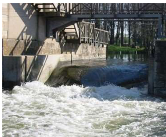
Figure 29 : Vanne-toit du parcours d'eau vive de Tournon Saint-Martin
