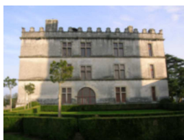
façade sur jardin Nord Ouest
