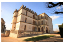
façade principale entrée Sud Est
