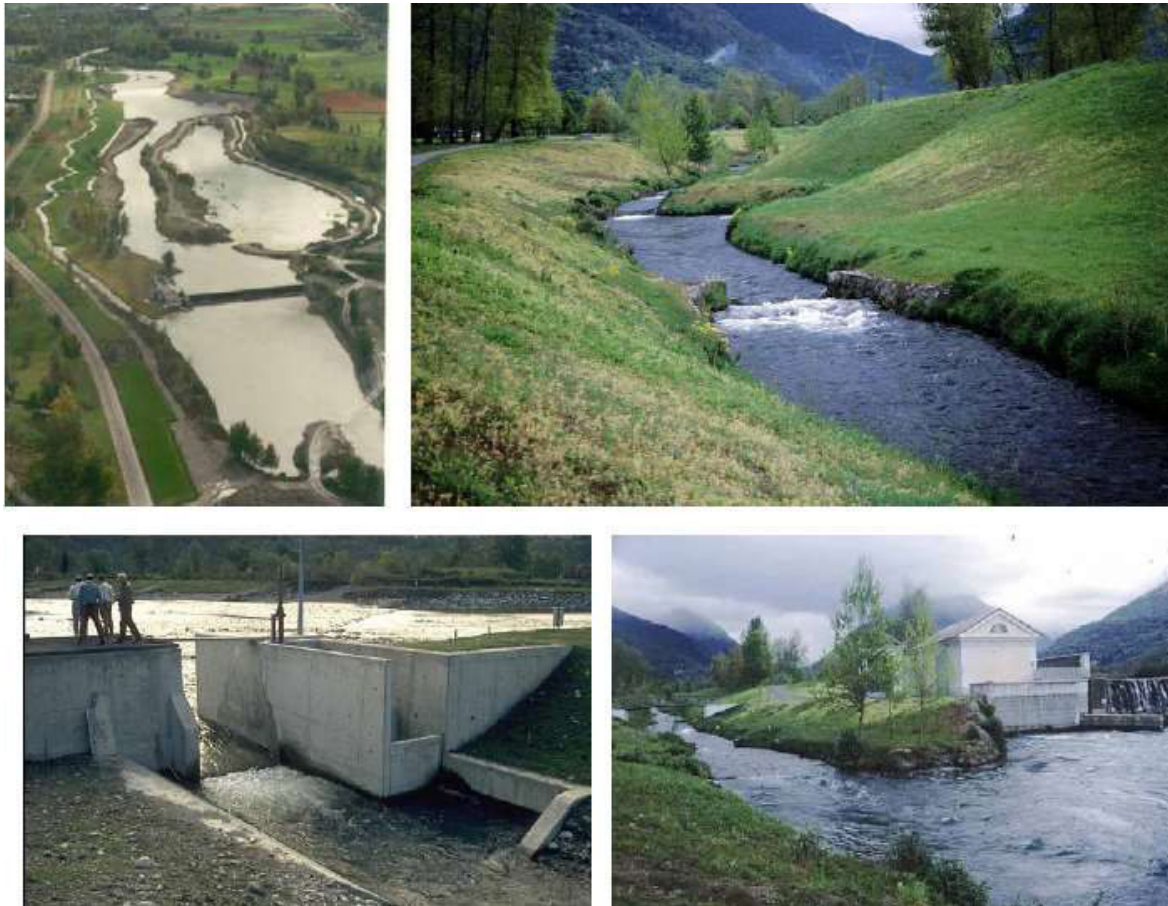
Figure 44 : Vue de la rivière de contournement du lac des Gaves
