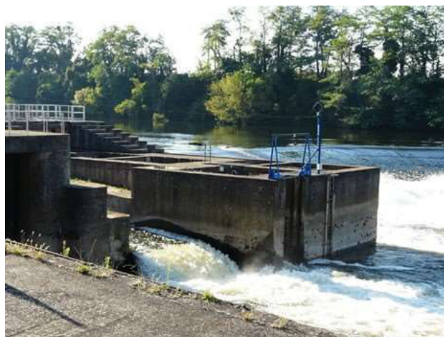
Figure 3. Passe à bassins en rive droite du barrage usine de Bergerac
