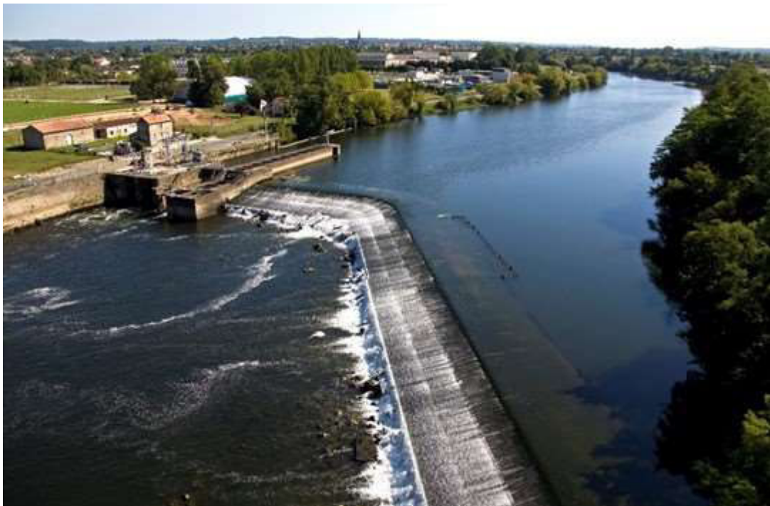
Figure 2. Vue aérienne du barrage usine de Bergerac
