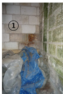
• LE SALON DORÉ (1er étage) La dépose des tentures murales et la mise en oeuvre d'un enduit à la chaux a permis d'assainir la pièce et de réduire pour partie l'hygrométrie ambiante.
