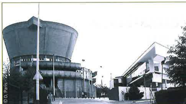
Le château d'eau est relié à la médiathèque par un parvis commun.
