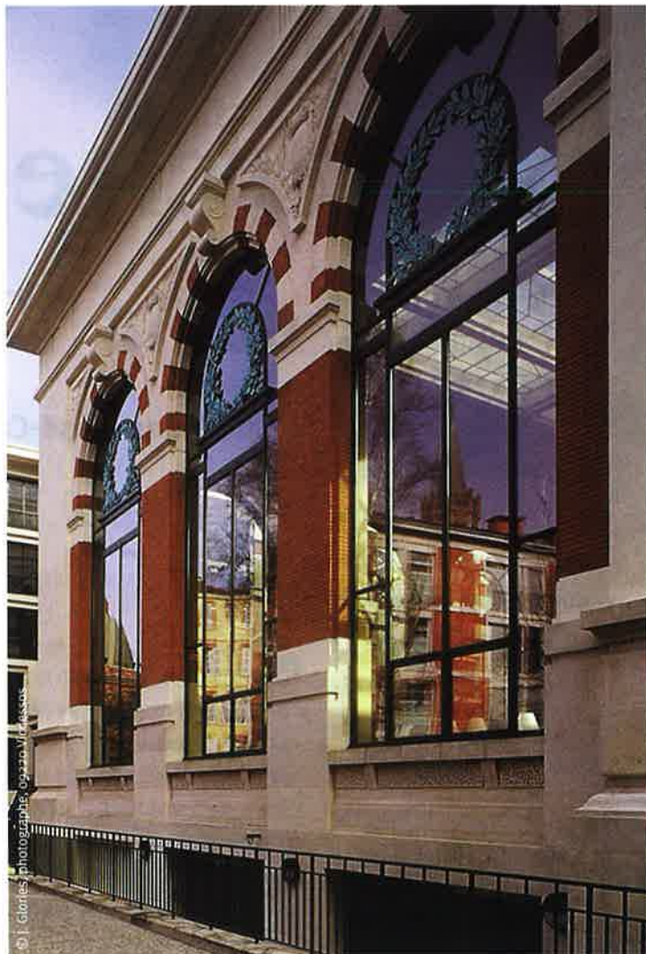
Élévation extérieure latérale de la salle de lecture.
