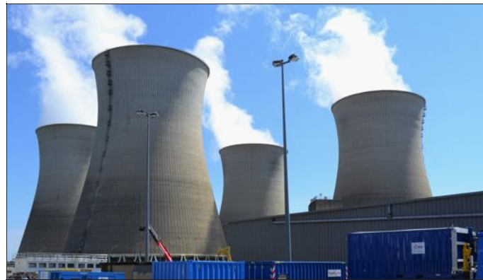
La centrale du Bugey et ses quatre réacteurs.
