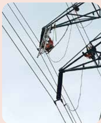
Travailleurs de lignes sur le changement d'isolateurs à Rimouski, ligne à 315 kV, Jonathan Nadeau, délégué.
