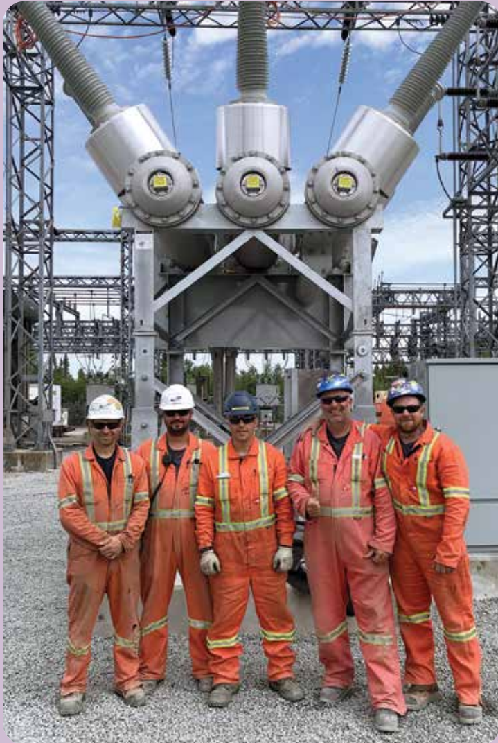
Chantier : poste Matagami. Entrepreneur : TCI. Les confrères Éric Dumas (contremaître) Patrick Bérubé (contremaître), Luc Sauvé (contremaître), Stéphane Papineau (RDT) et Mike Lowrey . Représentant : Patrick Brière .
