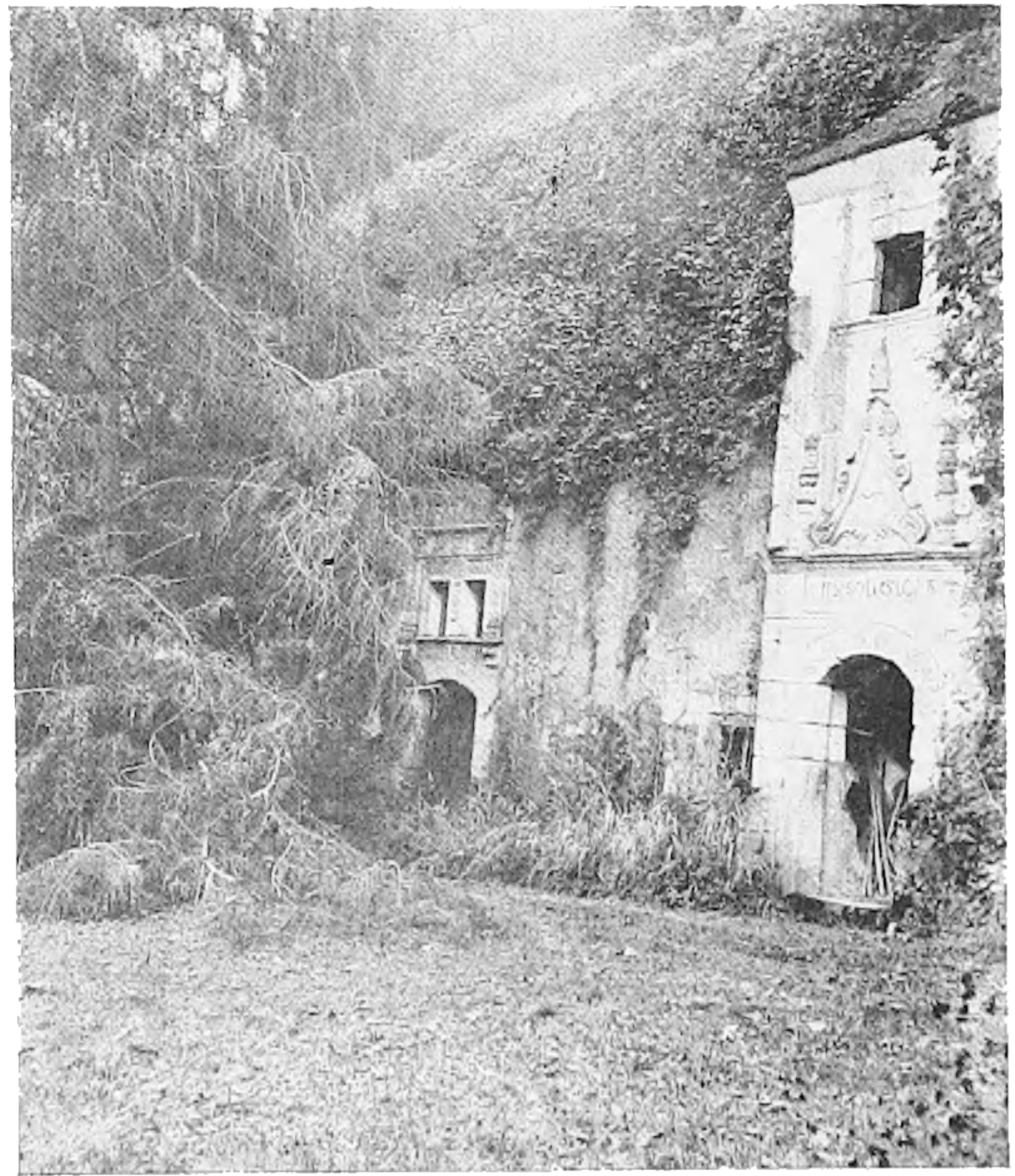
Entrée des dépendances taillées dans le roc.
