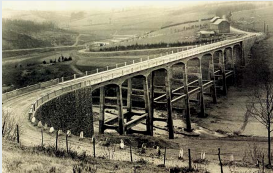
5. Le système structurel multivoûtes du barrage de Butgenbach en cours de chantier. (Guy Lejoly, La construction des barrages sur la Warche ). © D.R.
