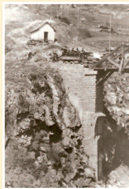
Pont remis en état par le génie (ECPAD).
