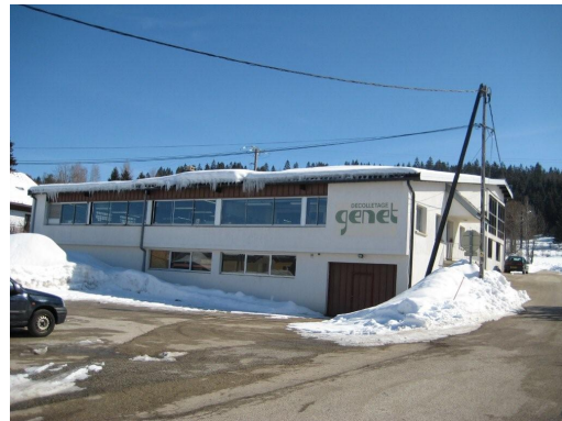
Usine décolletage Genet 55 chemin du Bévet La Mouille
