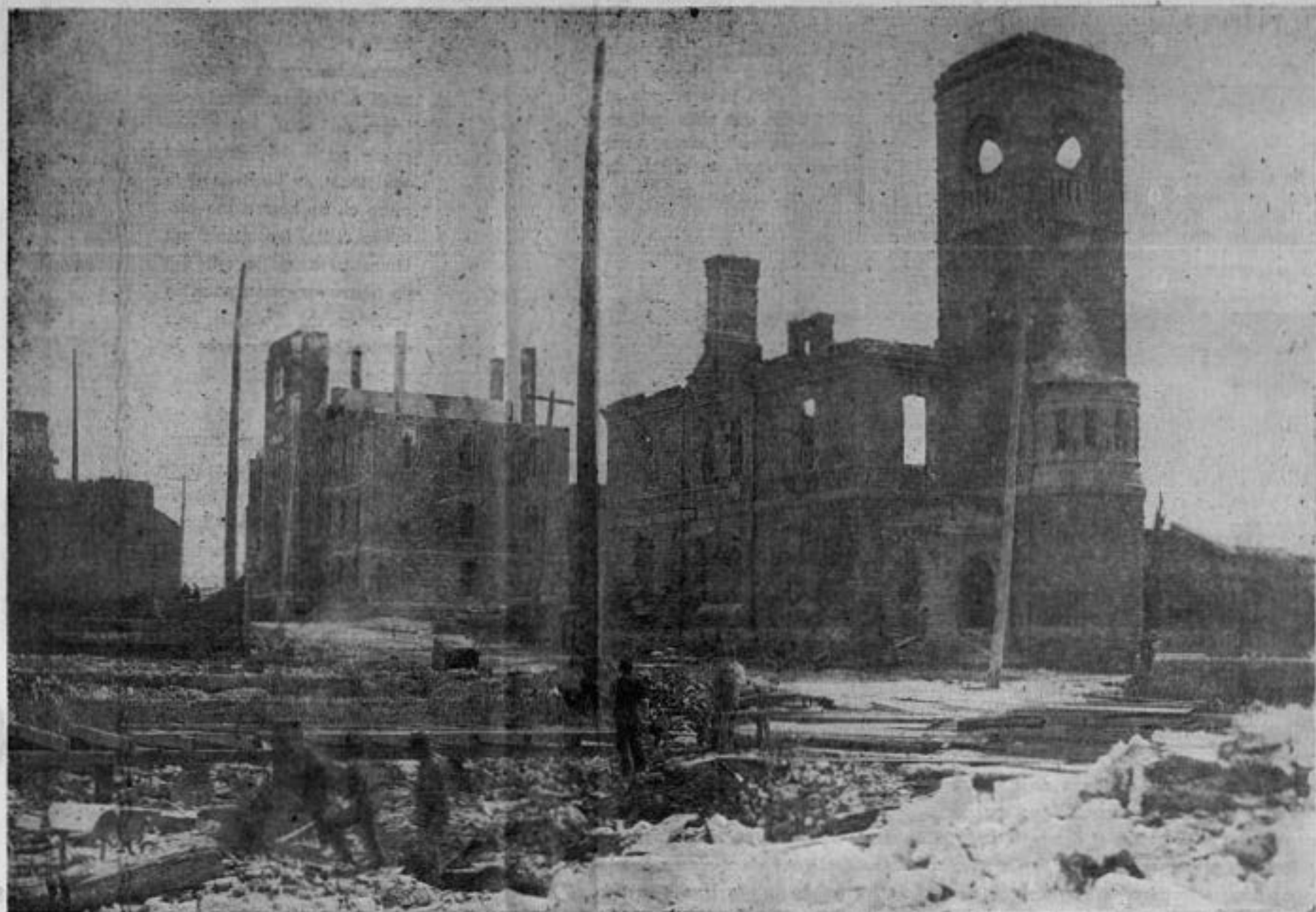
ET VOILA TOUT CE QUI RESTE APRES LE "GRAND FEU DE 1900". ON RECONNAIT LE BUREAU DE POSTE, LE PALAIS DE JUSTICE, AU PREMIER PLAN GAUCHE SE TROUVAIT L'HOTEL IMPERIAL. CETTE PHOTO FUT PRISE DU COIN DES RUES PRINCIPALE ET LAVAL.
