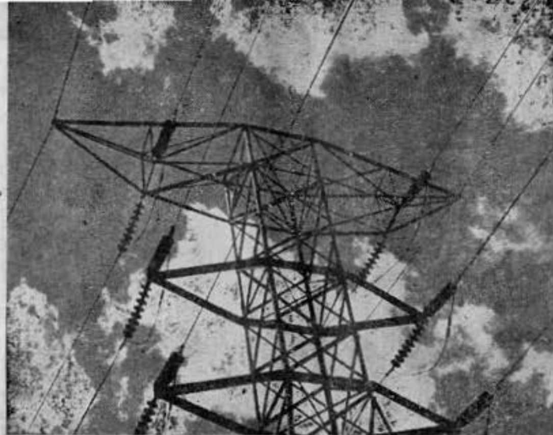
Aménagement de la Gatineau Power Company à Châteauguay et Farmington, où l'on met en valeur le débit de la Gatineau, au service de toute une grande région.
