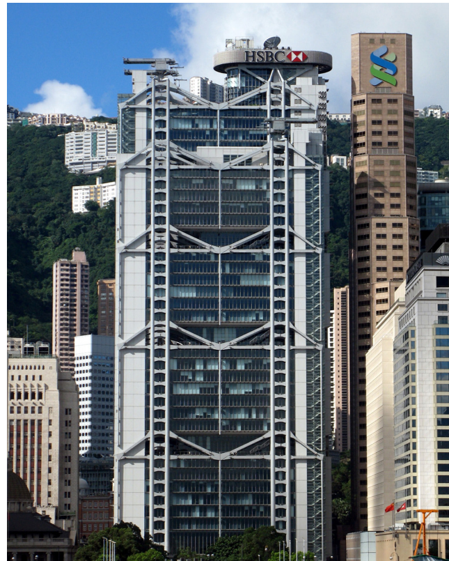
▶ Figure 2.7. Siège de Hongkong and Shanghai Banking Corporation (HSBC), 1979-86, Hong Kong, Chine. Situé dans le centre de Hong Kong, le siège de la HSBC a été conçu par l'architecte britannique Norman Foster et le cabinet d'ingénierie structurelle Arup Partners basé à Londres. C'est un exemple de la phase « high-tech » de l'architecture moderne, qui met clairement en avant le système structurel et les matériaux du bâtiment ainsi qu'un niveau important de préfabrication. La structure auto-portante extérieure prononcée et le placement des pôles de services exposés sur les côtés extérieurs des tours permettent de libérer l'intérieur de toute structure. Il comprend un atrium de dix étages, au sommet duquel se trouve un miroir réfléchissant la lumière à travers l'atrium, vers le rez-de-chaussée.
