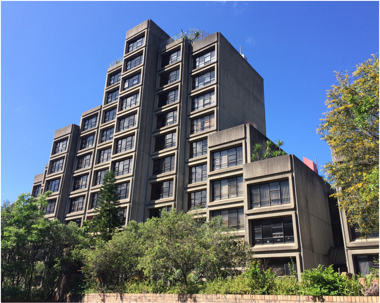
▲ Figure 1.14. Bâtiment Sirius, 1978-79, Sydney, Australie. Situé dans le quartier historique de Sydney appelé The Rocks, le complexe résidentiel Sirius a été construit pour héberger les résidents de la classe ouvrière déplacés en raison du réaménagement urbain. Conçu par le néerlandais Tao Gofers de l'Office of the Government Architect (Nouvelle-Galles du Sud), le projet était le fruit d'un accord conclu pour mettre fin à un « Green Ban », un outil unique et réputé d'action pour la préservation civique lancé en Australie dans les années 1970. Dans le cadre d'un Green Ban, les syndicats de constructeurs retiraient leur main-d'œuvre des sites de réaménagement pour aider les communautés locales à protéger des quartiers historiques, des logements de la classe ouvrière et des espaces verts. Ce mouvement a fini par mettre un terme au réaménagement en masse de la zone et a entraîné la mise en place d'une législation sur le patrimoine.
