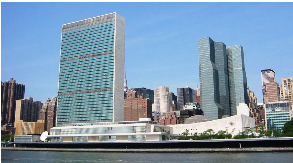
▲ Figure 6.11. Siège des Nations unies, 1948-52, New York, New York, États-Unis. Le siège de l'ONU occupe un site de sept hectares le long de l'East River à New York, comprenant le bâtiment de l'Assemblée générale, courbé et vitré (visible en bas à droite au premier plan de la photo), le bâtiment des conférences, bas et horizontal (en bas à gauche au premier plan), et le secrétariat de 39 étages (à gauche). Une bibliothèque a été ajoutée en 1961. Conçu par plusieurs architectes internationaux travaillant sous la direction de l'américain Wallace Harrison, le complexe était en grande partie un compromis entre les conceptions modernistes du Brésilien Oscar Niemeyer et du Français né en Suisse Le Corbusier, avec la contribution d'autres architectes. Le complexe est reconnu à travers le monde comme un symbole des Nations unies.
