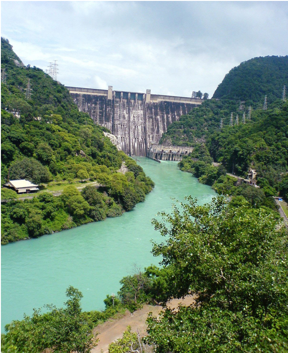
Figure 3.1. Barrage de Bhakra, 1963, Bilaspur, Himachal Pradesh, Inde. D'une hauteur de 226 mètres, ce barrage-poids en béton est le plus haut d'Inde et compte parmi les plus élevés du monde. Il barre le Sutlej pour créer le troisième plus grand réservoir d'Inde, accueillant les excédents d'eau pendant la mousson, avec une libération régulée tout au long de l'année. Le barrage alimente le canal de Bhakra qui irrigue environ 5 millions d'hectares de champs dans le Pendjab, l'Haryana et le Rajasthan. L'électricité produite par les générateurs du barrage est distribuée vers l'Himachal Pradesh et cinq états voisins.
