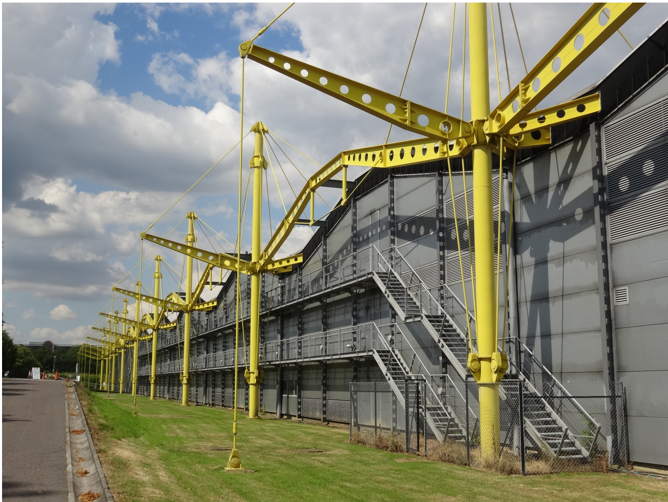
▲ Figure 4.3. Dépôt central de Renault, 1982, Swindon, Angleterre. Au cours des années 1970, le Groupe automobile français Renault a commencé à se développer à l'échelle mondiale. Conçue par l'architecte Norman Foster, né à Manchester, dans un style high-tech britannique, cette installation industrielle particulièrement novatrice incluait de nouveaux matériaux, technologies et solutions conceptuelles pour un intérieur modulaire et pouvant être agrandi. Renault a déménagé en 2001 et la structure est désormais connue sous le nom de Spectrum Building.
