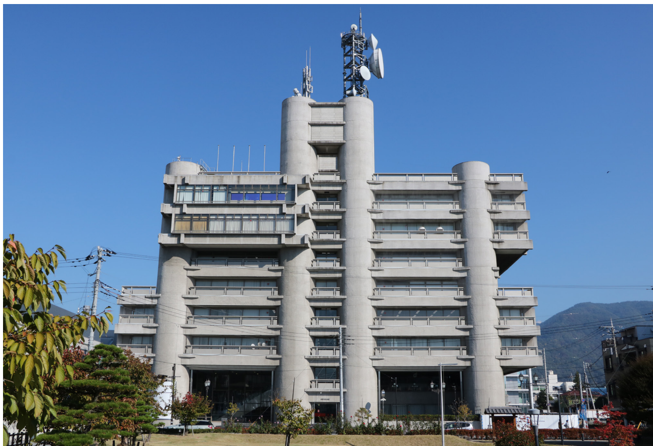
▲ Figure 5.11. Centre de diffusion et de presse Yamanashi, 1961-66, Kōfu, Préfecture de Yamanashi, Japon. Conçu par l'architecte métaboliste japonais Kenzo Tange, ce bâtiment en béton coulé sur place a été conçu pour accueillir trois services de communication majeurs : une usine d'impression de journaux, une station de radio et un émetteur de télévision. Ces services étaient reconnaissables dans la conception de la façade : le matériel d'impression situé au rez-de-chaussée, des studios clos aux étages supérieurs, des bureaux aux parois en verre avec balcons, et des colonnes de service cylindriques pour les escaliers, les ascenseurs et la CVC. En outre, des espaces ouverts et des transitions fluides avec l'espace urbain extérieur ont été inclus.
