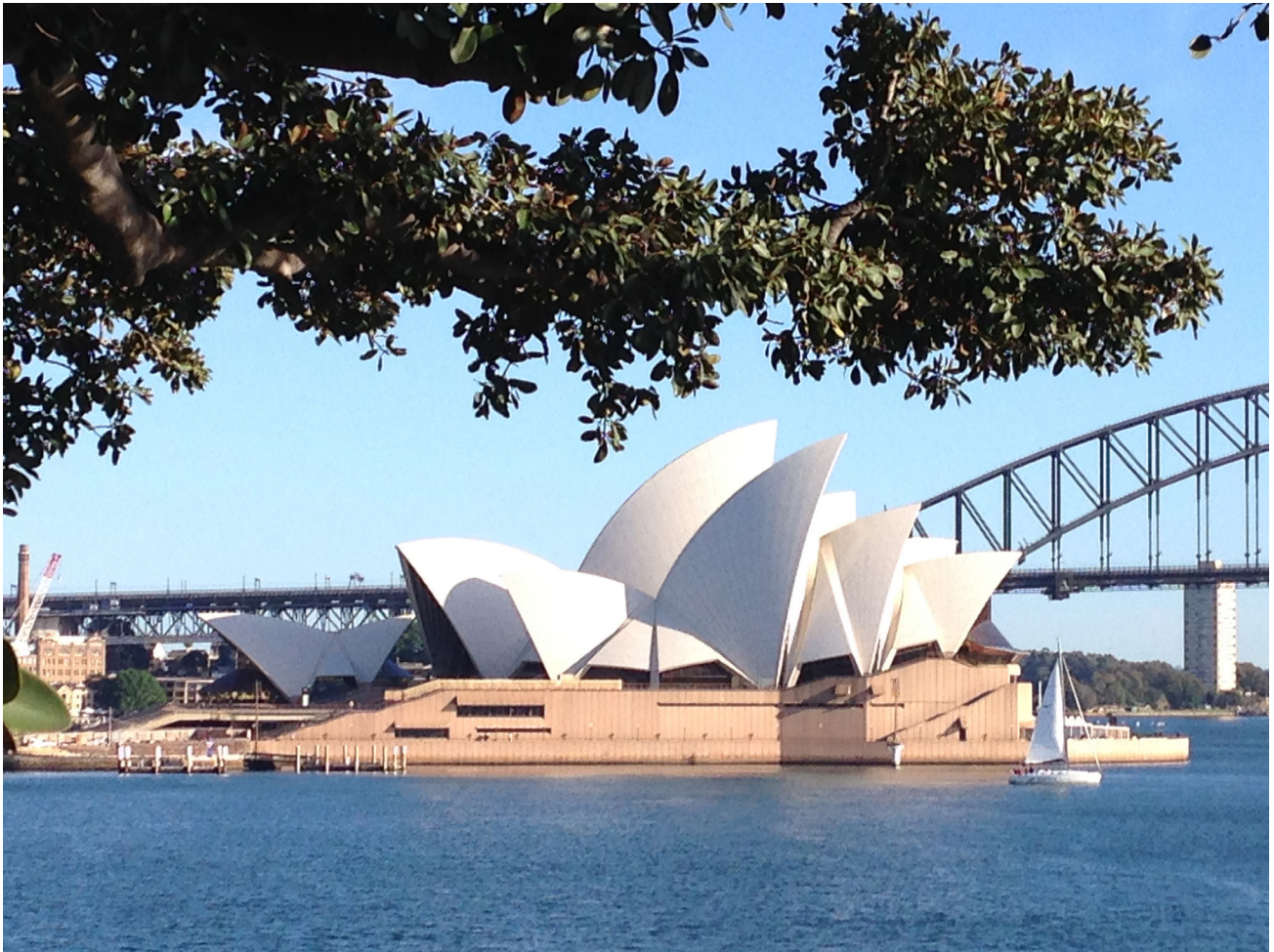
▲ Figure 2.5. Opéra de Sydney, 1958-73, Sydney, Australie. Conçue par l'architecte danois Jørn Utzon, avec le Britannique Ove Arup comme ingénieur des structures, la structure se compose de trois groupes de coquilles voûtées en béton et interconnectées, placés sur un podium monumental surplombant une péninsule portuaire. Pour comprendre les forces complexes auxquelles les panneaux préfabriqués incurvés et les arches allaient être soumis, les créateurs ont été parmi les premiers à utiliser des ordinateurs pour l'analyse structurelle. Le site a été inscrit sur la Liste du patrimoine mondial en 2007 en qualité de « chef-d'œuvre du génie créatif humain ».
