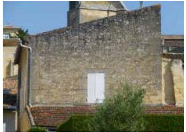
La maçonnerie enduite à pierre vue sur la façade secondaire.
