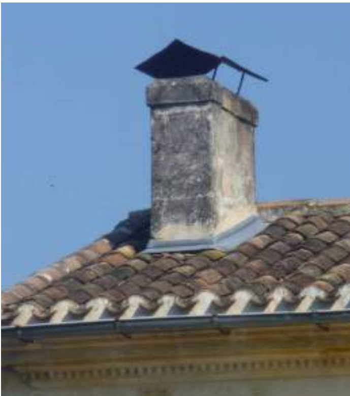
Corniche en pierre, gouttière.
