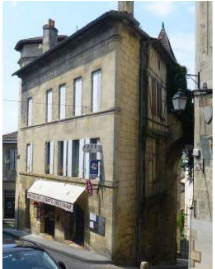
Façade est reconstruite (au XIXe rue Guadet) et façade nord pan de bois XV-XVI, maison dite de la Cadène. MH
