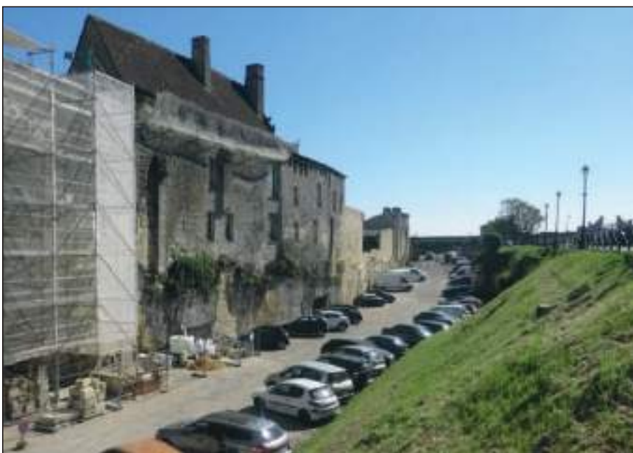
Un stationnement dans les douves qui porte atteinte à leur valeur patrimoniale
