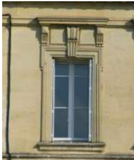
Maison en bas de la rue Guadet : beau XIX e , cohérence de la composition architecturale et des détails d'art de bâtir cohérents.
