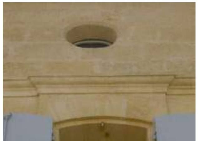
La maçonnerie en pierre et la modénature, détails.
