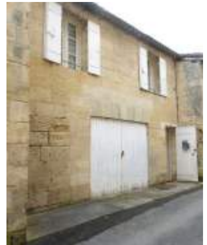
Maison sur le rempart, pas d'intérêt extérieur/intérieur , possibilité de remplacer ? Gris Clair ?
