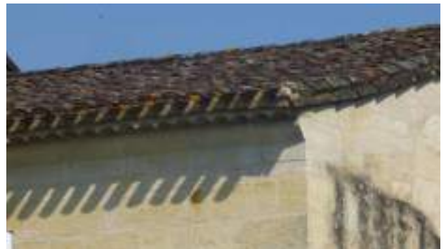
Egout tuile canal : sur génoise et corniche.
