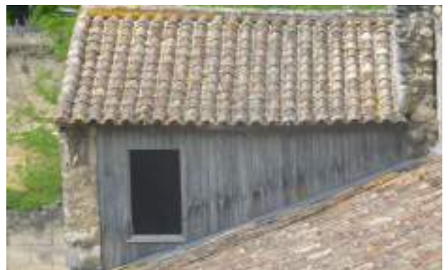
Cas ponctuel d'un bardage bois, façade arrière.
