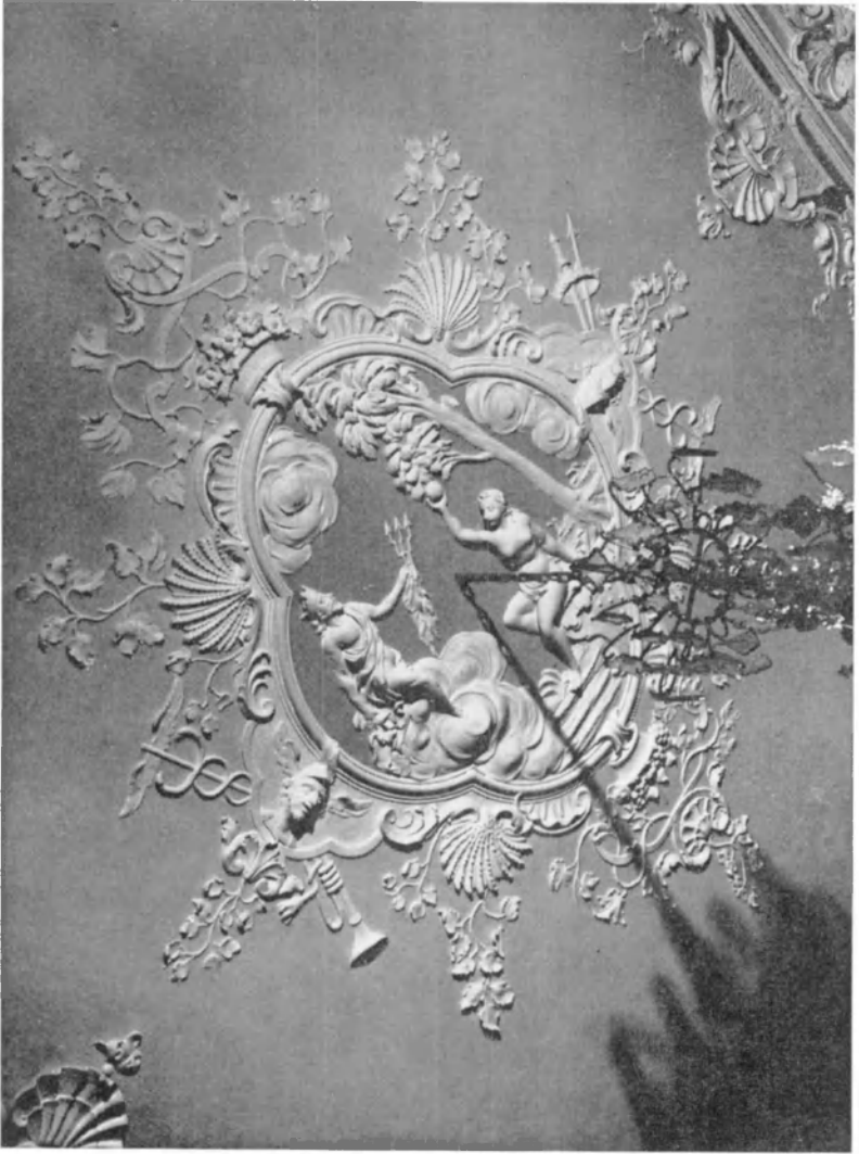
FIG. 4. Plafond en stuc du salon rouge de l'hôtel d'Ansembourg (détail). Photo F. Niffle, Liège.
