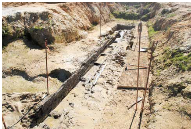
Une des conduites en cours de démontage. La paroi de bois repose, grâce à un assemblage en queue-d'aronde, sur une série d'entretoises. © Inrap
