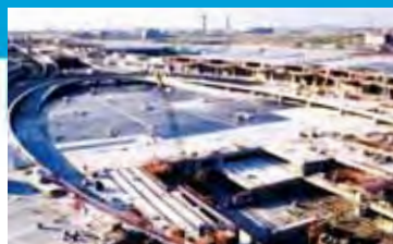
Extension de l'aérogare II de Roissy-Charles de Gaulle, modules D et C, un des grands chantiers métropolitains réalisés par Dumez entre 1985 et 1990.
