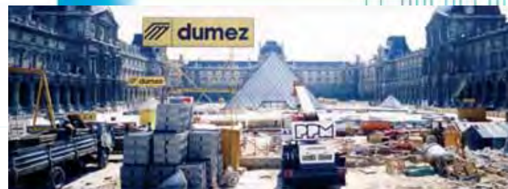
Le Grand Louvre. Accompli dans un délai record de 27 mois, ces travaux sont une véritable réussite technique : Dumez utilise le plus beau béton du monde, un béton blanc architectonique, réplique parfaite de la pierre de Chassagne.
