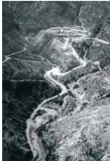
Barrage de Zimapan au Mexique en 1991 : un des derniers grands ouvrages de génie civil dans le monde signé Dumez !
