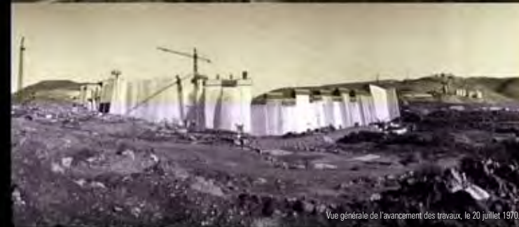
Vue générale de l'avancement des travaux, le 20 juillet 1970.
