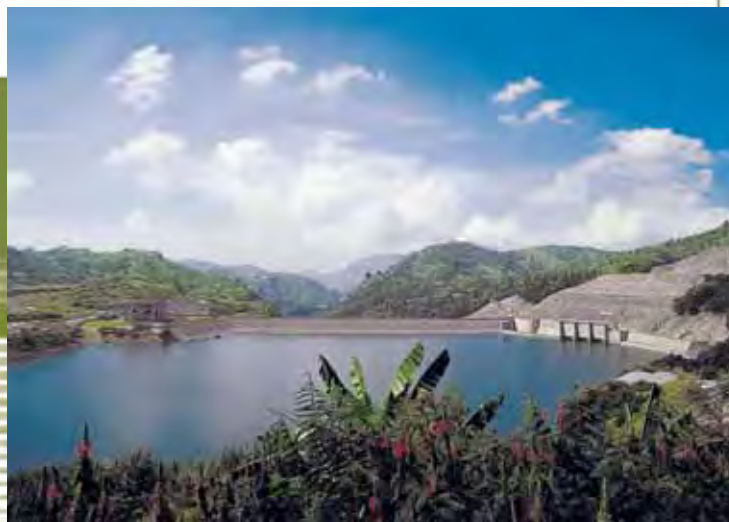
L'aménagement hydroélectrique de Saguling sur l'île de Java en Indonésie est réalisé en association avec Spie Batignolles (1981-1985).
