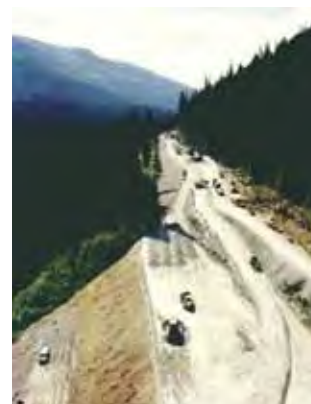
Un chantier référence au Canada : le tunnel de Rogers Pass en Colombie Britannique (1986), long de 14,5 km.
