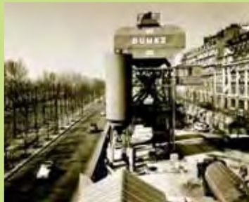
Travaux de la voie express rive droite à Paris (1965).
