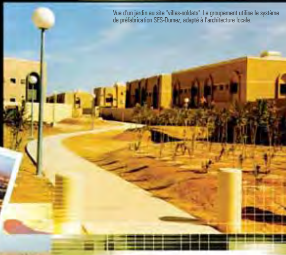
Villas de soldat avec au second plan le minaret et le dôme de la mosquée (1984).
