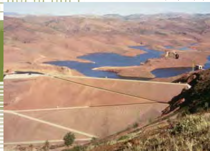
La construction du barrage de Ait Chouarit (1983-1986) au Maroc fait partie du développement de la plaine de Haouz entourant la ville de Marrakech. Cet aménagement doit servir à l'irrigation de 35.000 hectares et alimenter en eau potable Marrakech. Sur ce grand chantier est testée une première liaison téléphonique entre un portable et un poste fixe au siège à Nanterre : le conducteur des travaux se trouvant au fond des fouilles peut être joint au téléphone par les responsables au siège.
