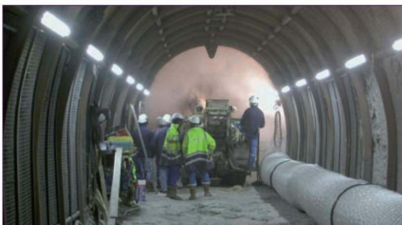
Figure 3 Creusement d'une galerie - Tournemire.
