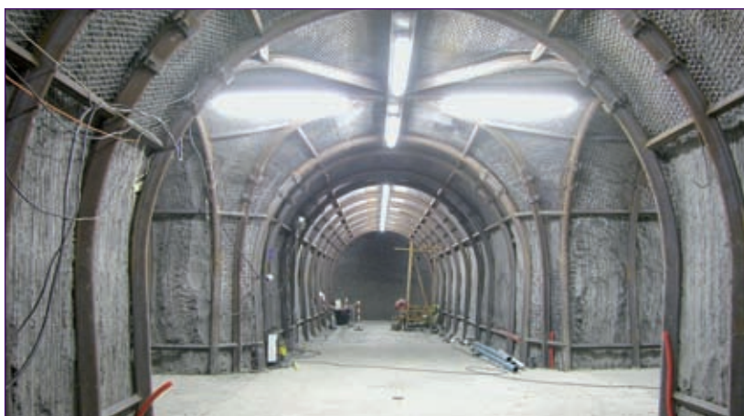
Figure 2 Galeries du tunnel de Tournemire.
