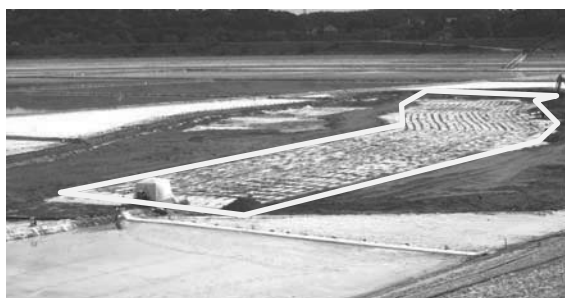
Figure 6. Vue depuis la crête de digue du bassin et de la zone instrumentée (en clair au centre).
