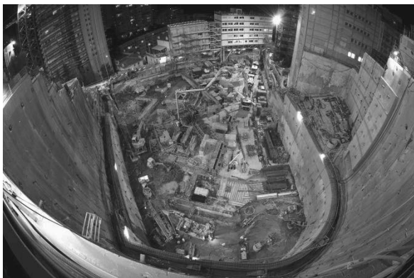
Figure 7: Etat d'avancement du chantier à \approx 40\% des excavations
