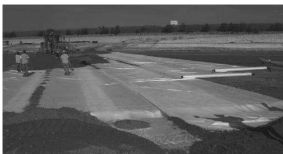
Figure 8 : Installation du géotextile de renforcement.
