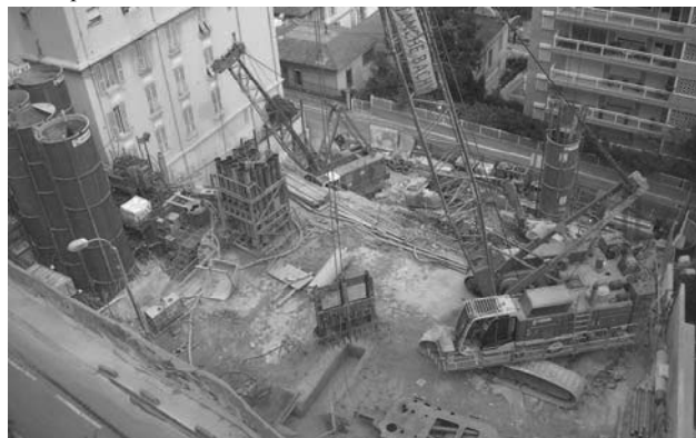
Figure 2. Vue générale du chantier en phase de forage
