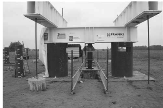
Figure 4 : Dispositif de chargement des pieux en compression.
