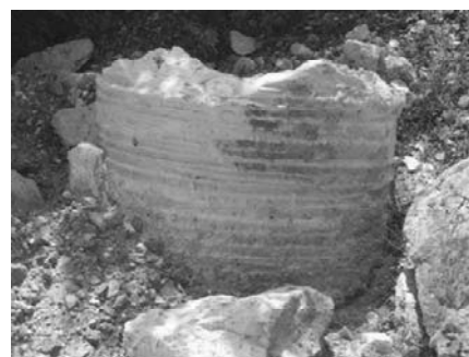
Figure 4. Etat de la surface d'un tronçon de colonne excavée
