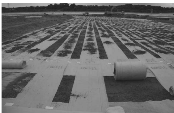
Figure 7. Pose de bandes capteur en fond de bassin.
