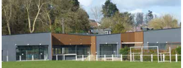
Fin des travaux de la maison des associations - vidéoprotection et mobilier inclus - acquisition d'un pare ballon 1 387 054 €
