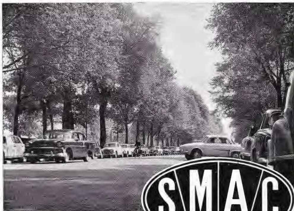
Paris - Quai d'Orsay Chaussee en Betonsmac
