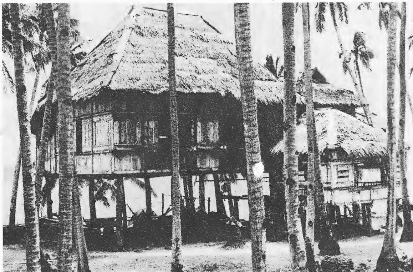
Maison traditionnelle sur les côtes philippines, construite en bambou, cocotier et palmier nipa.
