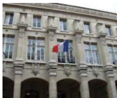
Un hôtel 4 étoiles de 7 200 m 2 prendra place dans les murs de la poste du Louvre.
