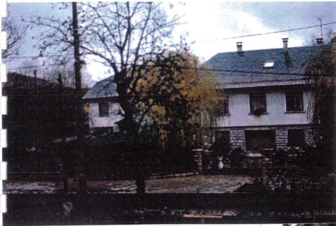
Lotissement Le Pré des Pommiers
