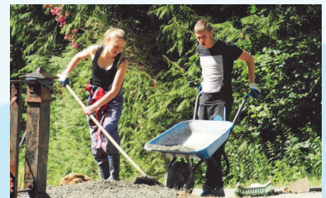
Réaménagement des abords du pont de Kerdéhel.
