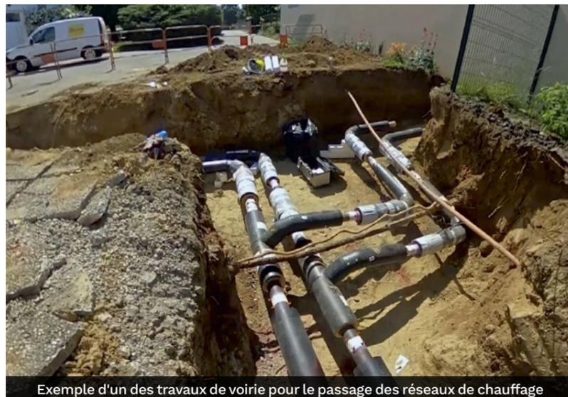
Exemple d'un des travaux de voirie pour le passage des réseaux de chauffage
