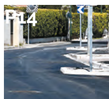
TRAVAUX DE VOIRIE
