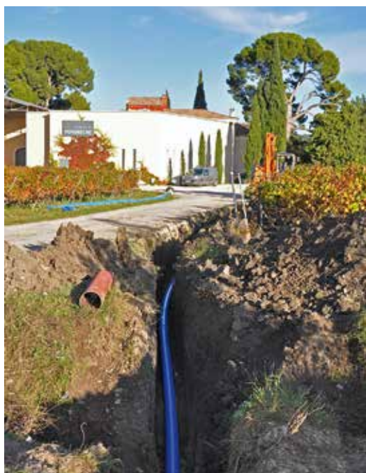
Travaux d'extension du réseau côté domaine de Fondrèche en 2013
