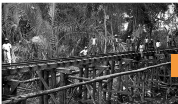
Phase de la construction du chemin de fer de Matadi à Léopoldville à la fin du XIX e siècle
