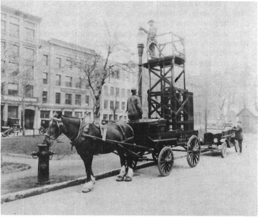
Au temps de la Montreal Light Heat & Power: Nettoyage et réparation des lampadaires.
