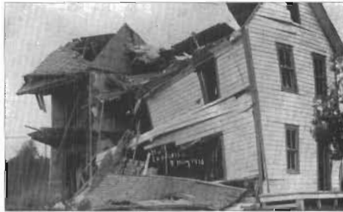
16. Maison située à soixante mètres de la General Explosives, après l'explosion du 8 mai 1910. (ANC, C6575, [mai 1910].)
