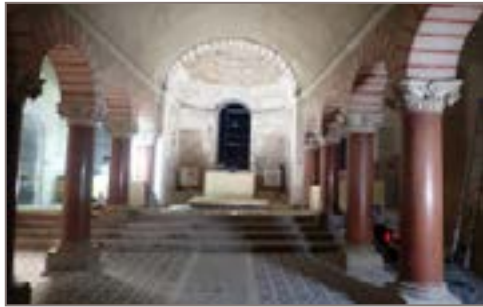
Crypte de Saint-Irénée en cours de restauration @Ch. Gaillard, SCVL
