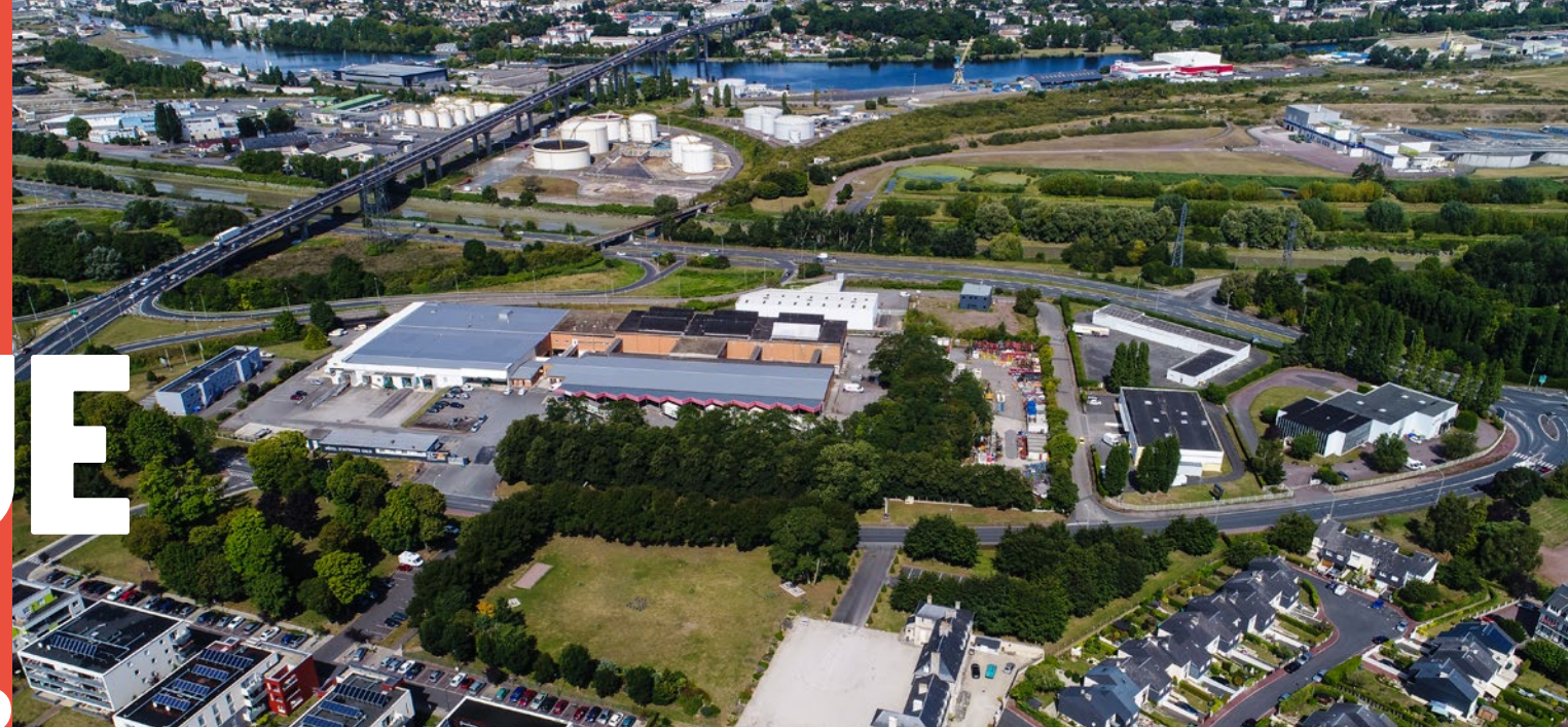
Situés au pied du viaduc de Calix, les DPC font l'objet d'une étroite surveillance.
