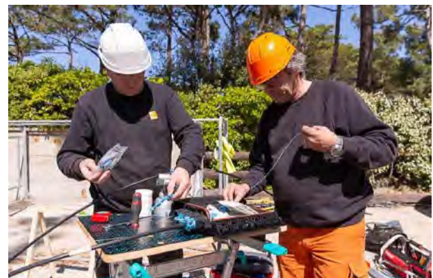
Travaux de jointage des câbles à terre
