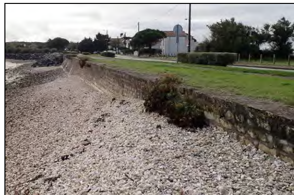
Ouvrage de protection maçonné – plage de blocailles
