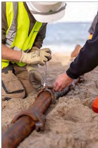
Mise en place des coquilles
