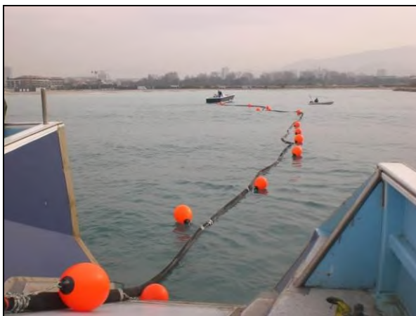
Exemple de tirage du câble depuis le navire
