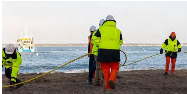
Tirage du câble sur la plage
