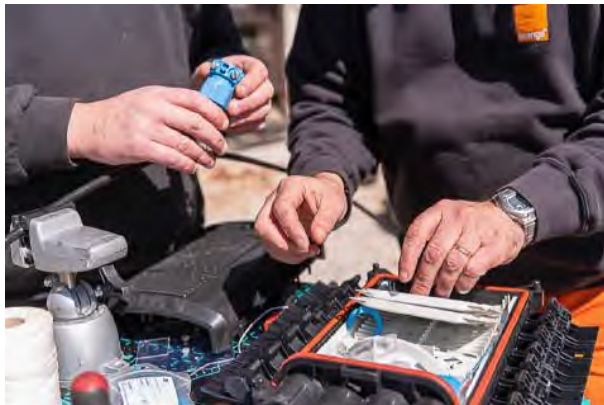
Travaux de jointage des câbles à terre
