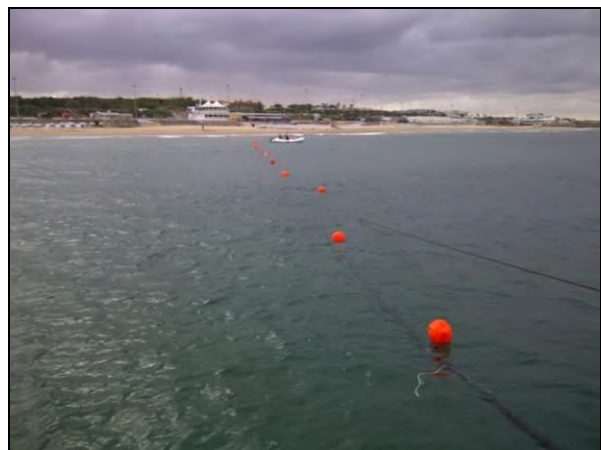
Exemple de tirage du câble depuis le navire
