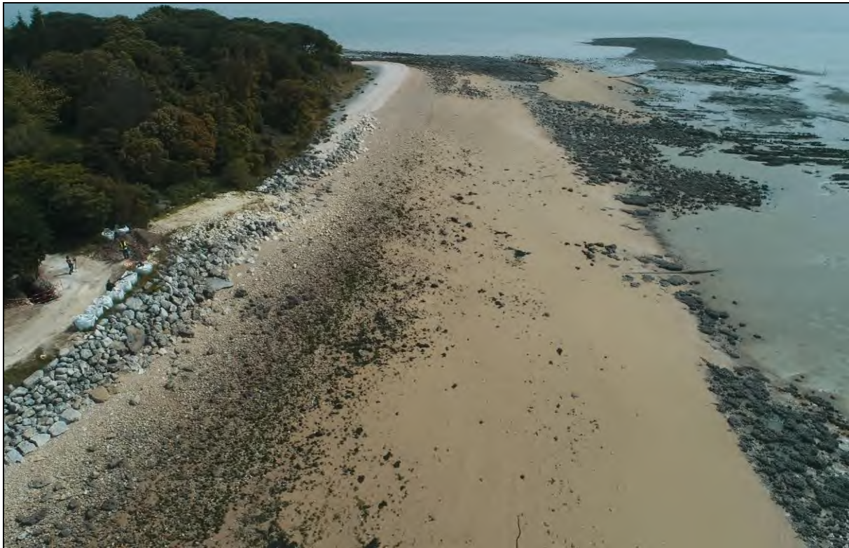
Protection en enrochements, plage de sables et blocailles
