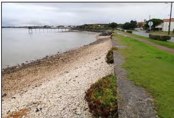
Ouvrage de protection maçonné – plage de blocailles
