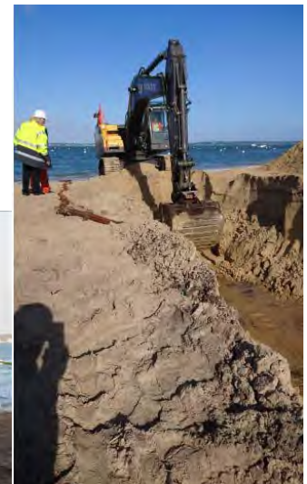
Ensouillage du câble
